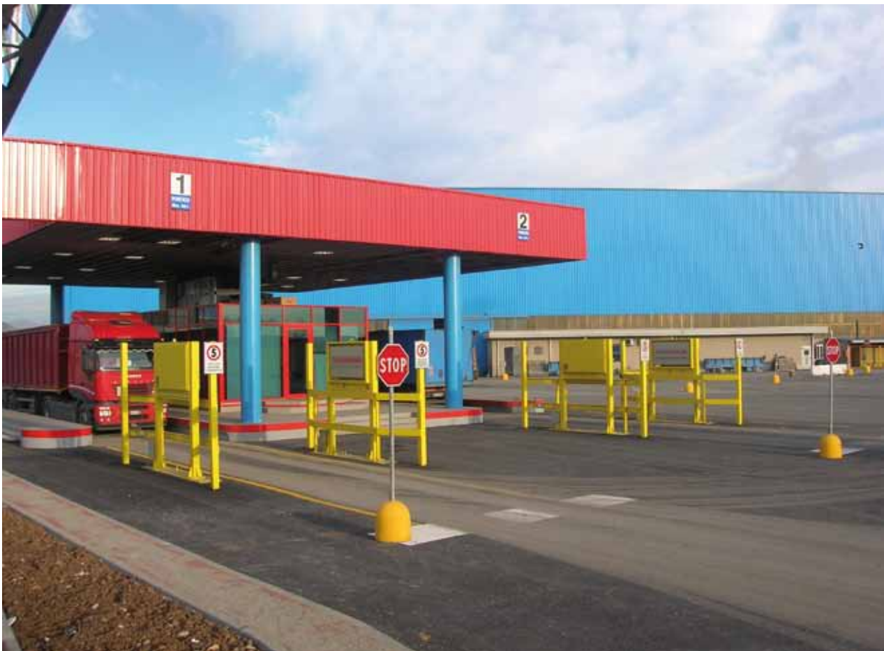
Ingresso pese con portali per il controllo radioattività
