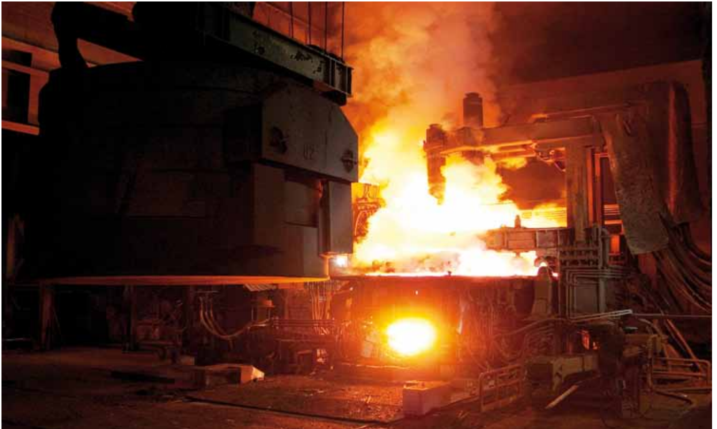
Fase apertura della volta del forno per il successivo caricamento rottame dalla cesta
