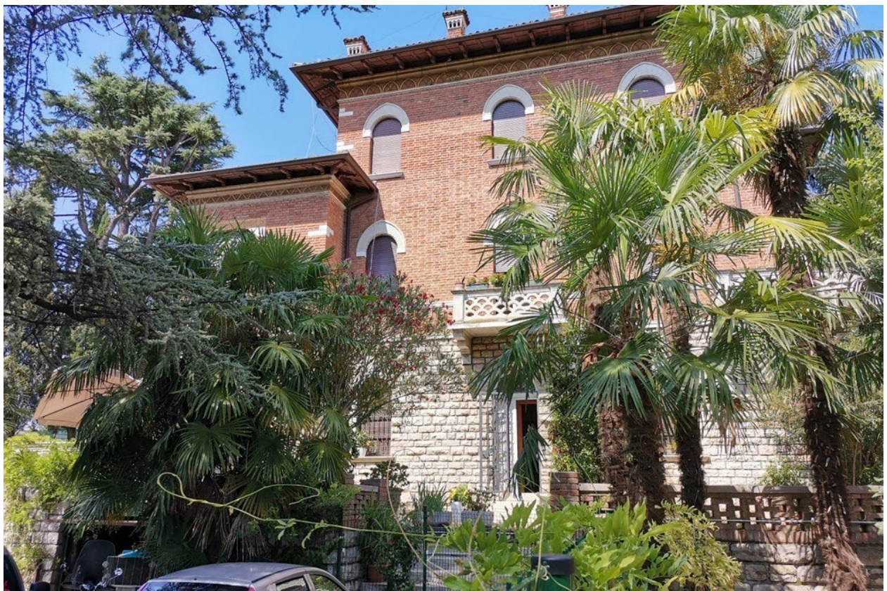
PALAZZINA - FRONTE SUD
