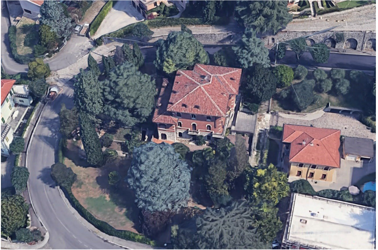
VISTA AEREA DA SUD
