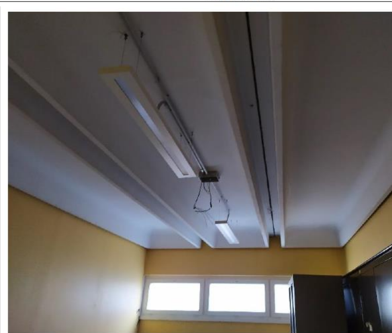
L'installazione delle plafoniere negli spogliatoi
