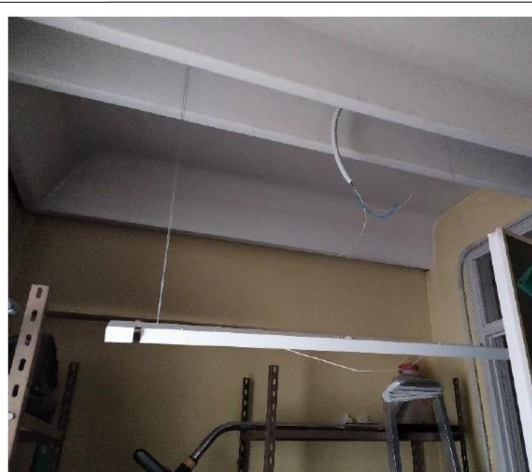
L'installazione delle plafoniere negli spogliatoi
