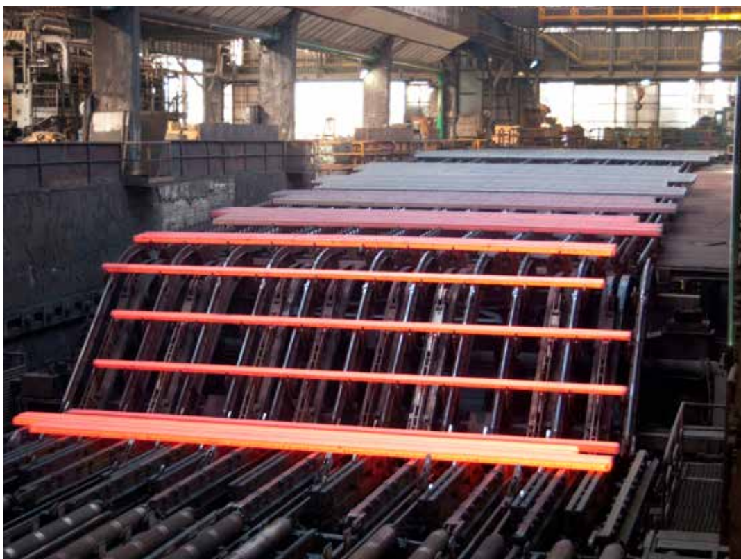
Particolare placca di raffreddamento delle colate continue
