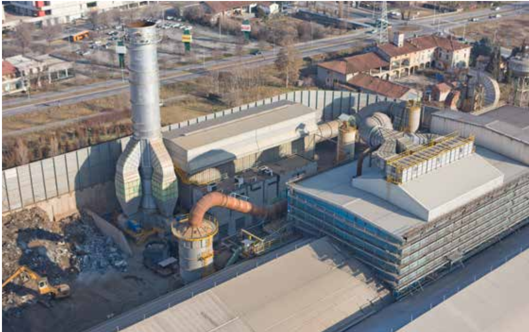
Vista dell'emissione E1 BIS
