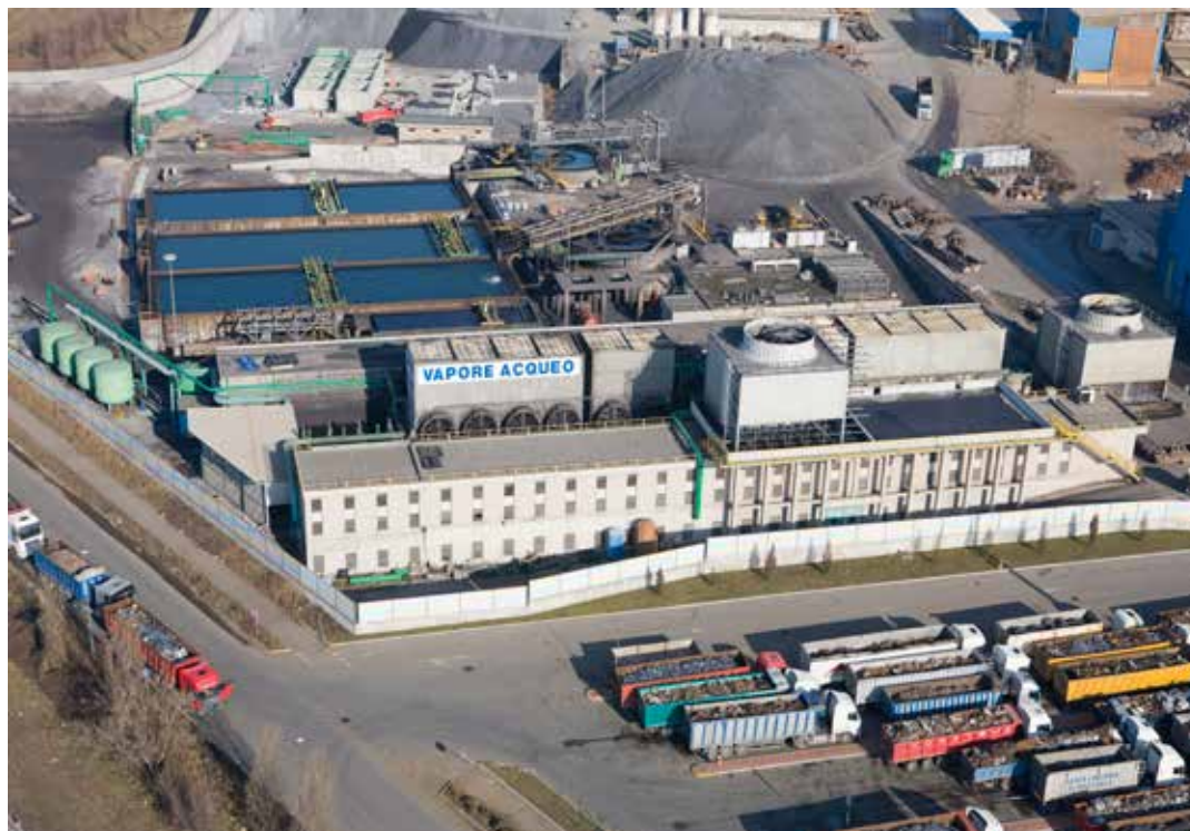
Torri evaporative e vasche di raccolta acque
