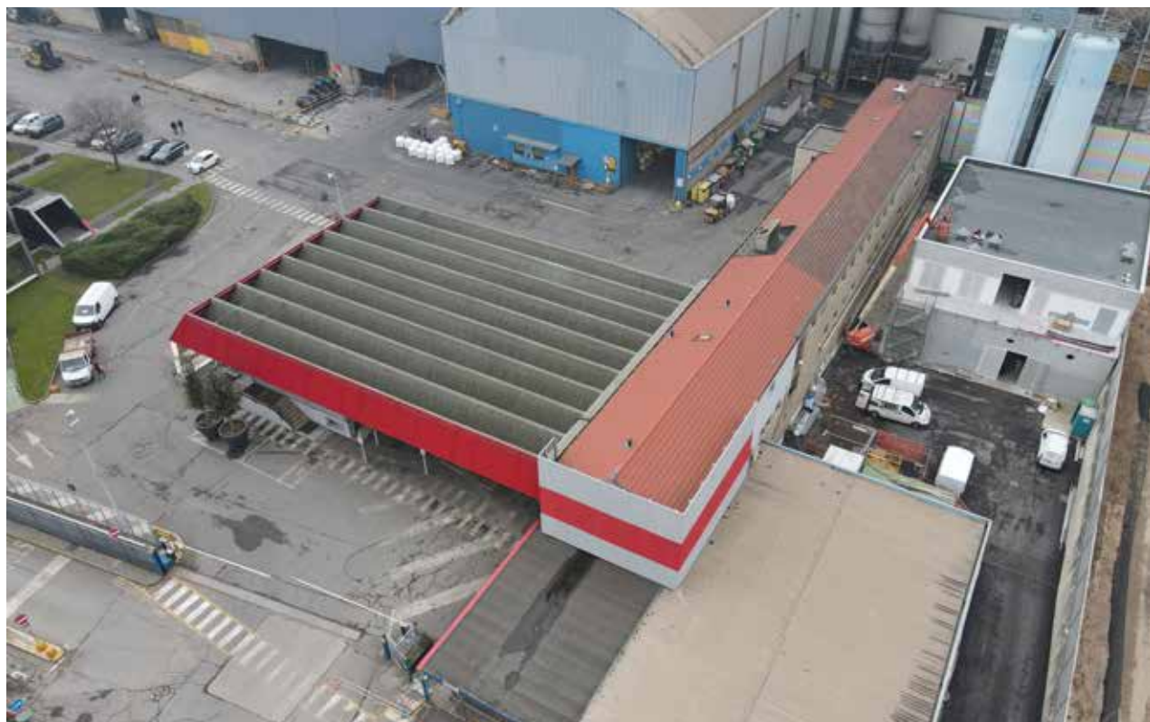
Lavori per la costruzione dell'impianto recupero calore
