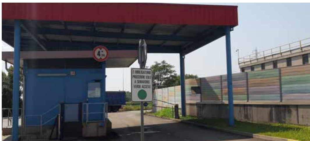
Pre-accettazione adibita al controllo documentale per l'accesso allo stabilimento
