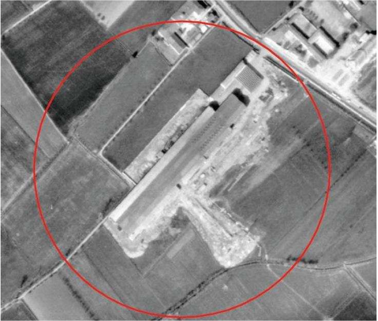
Figura 6: Particolare dell' area occupata dallo stabilimento (anno 1963).
