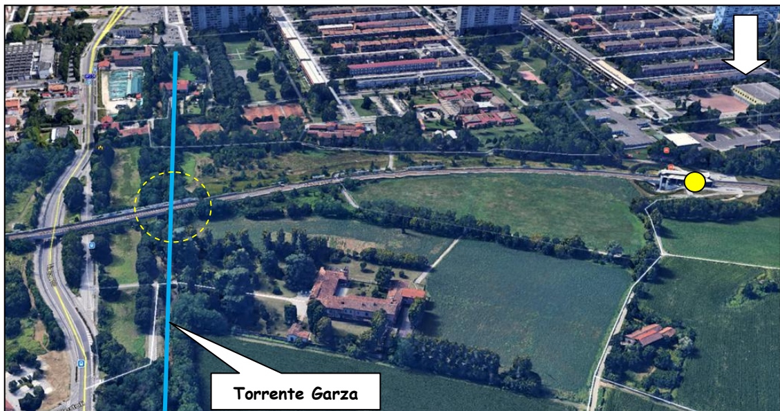
Vista aerea da nord con zona d'intervento "San Polo", stazione "San Polo Parco" e sovrappasso del piano rotabile della Metropolitana al torrente Garza
