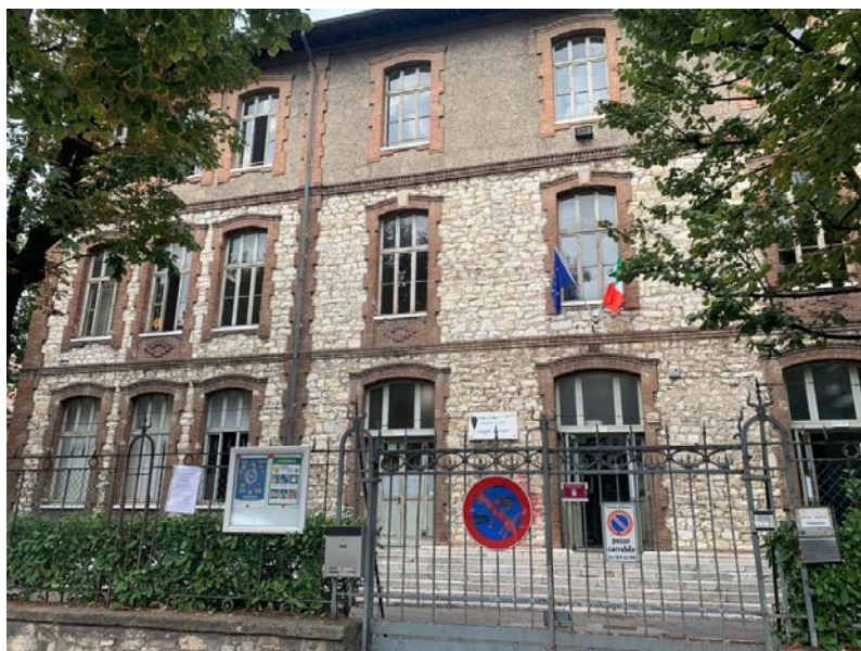
Foto 1: Vista ingresso su via Trento
