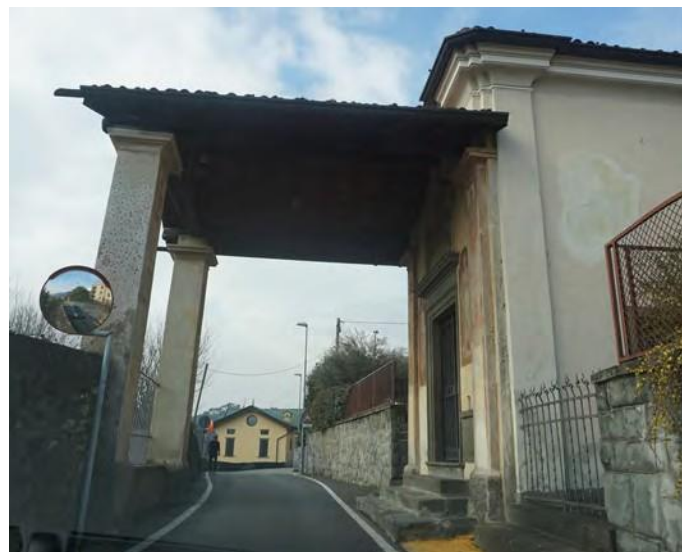
Percorso promiscuo sponda ovest dell'Oglio Sarnico
