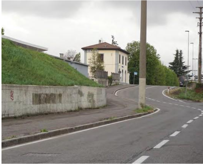
Percorso su ciclabile esistente adiacente alla stazione di Seriate
