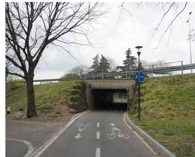
Sottopasso raccordo tangenziale ovest
