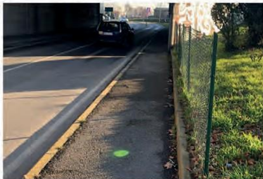
FOTO 2. Tratto di marciapiede da allargare a sud del cavalcavia (fotografia di Andrea Dadomo)
