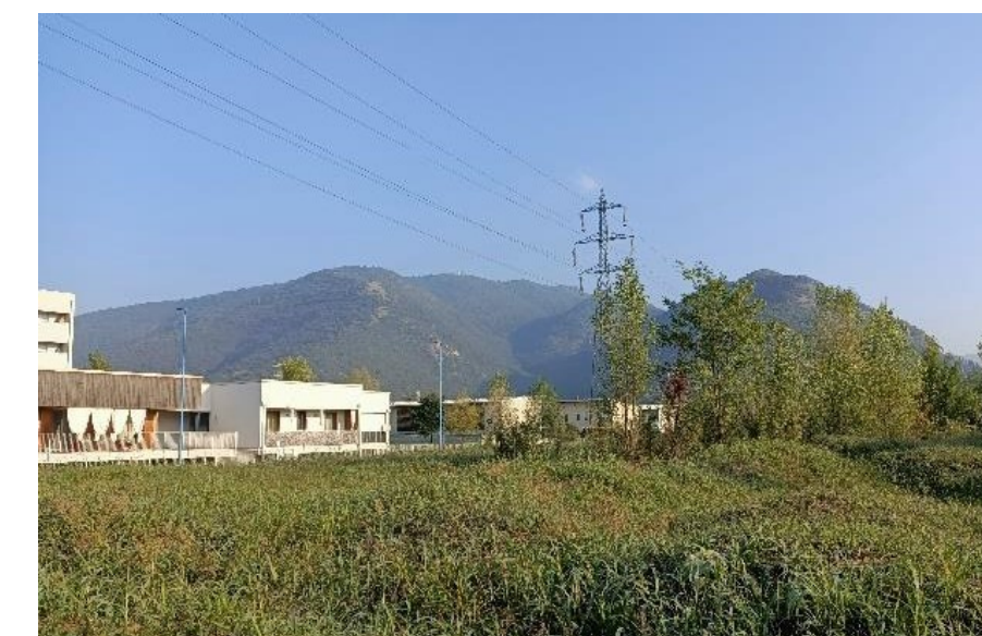
Cavi alta tensione direzione nord sud
