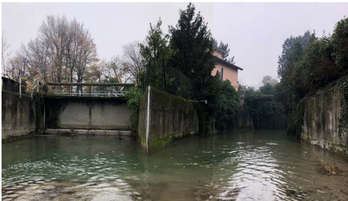
Figura 4-2: Sezione di biforcazione tra il fiume Garza (a sinistra, con paratoia) e lo scolmatore idraulico (a destra). Foto scattata in data: 09/12/2019.
