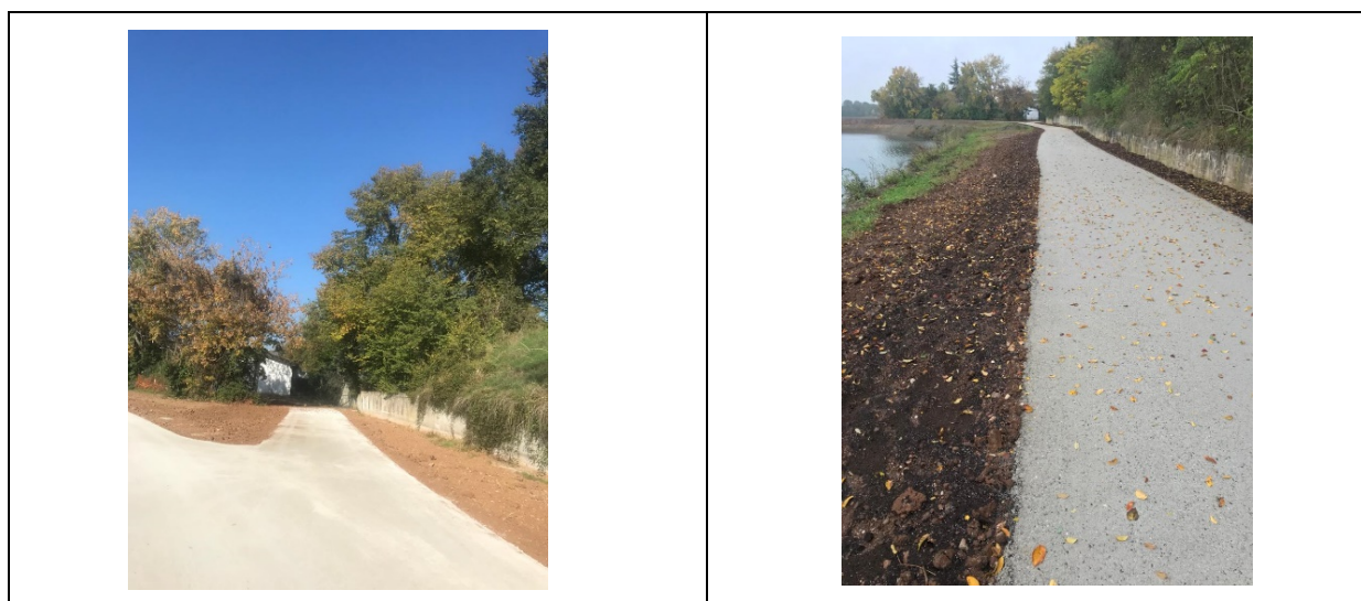
Figura 4-13: Esempi di finitura in Calcestre realizzata lungo il fiume Oglio.
