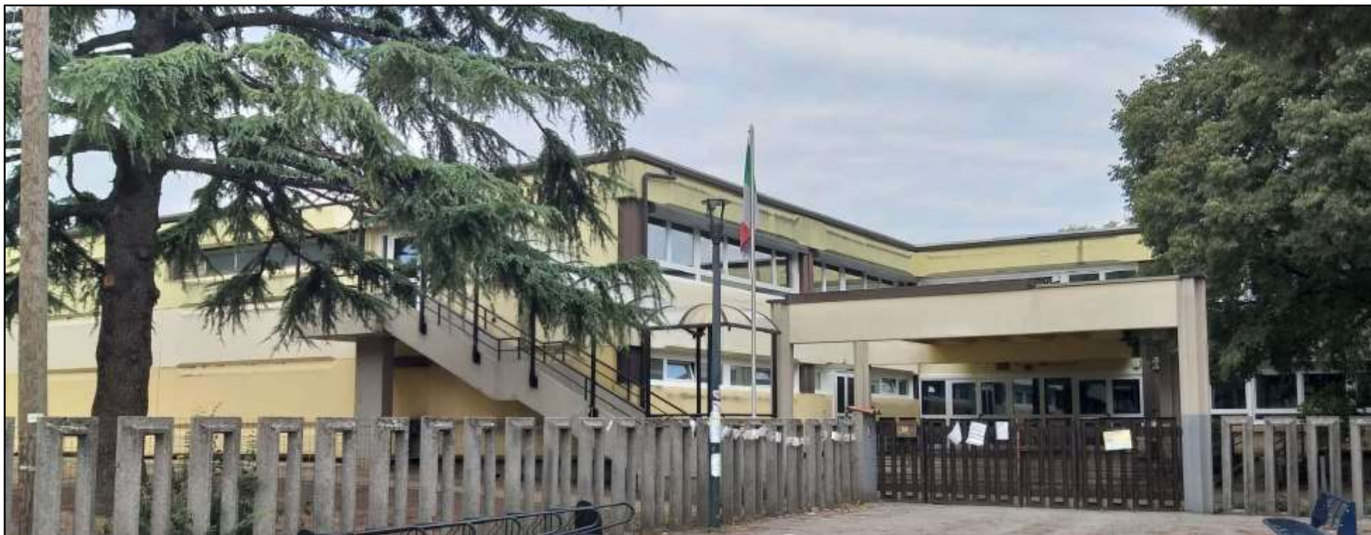
Vista facciata principale
