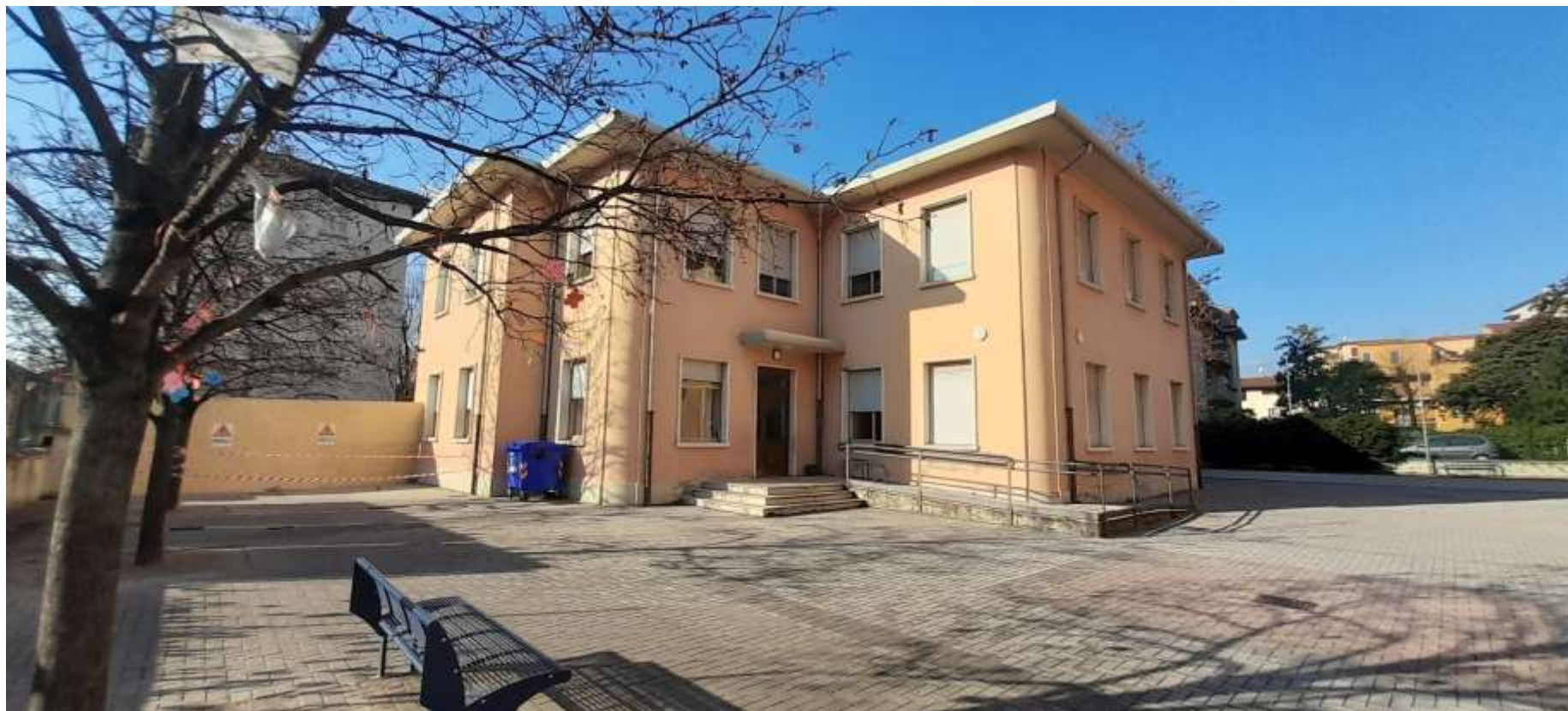
Vista Facciata principale
