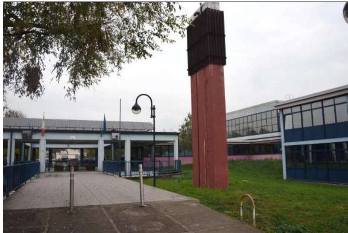
Vista facciata principale.
