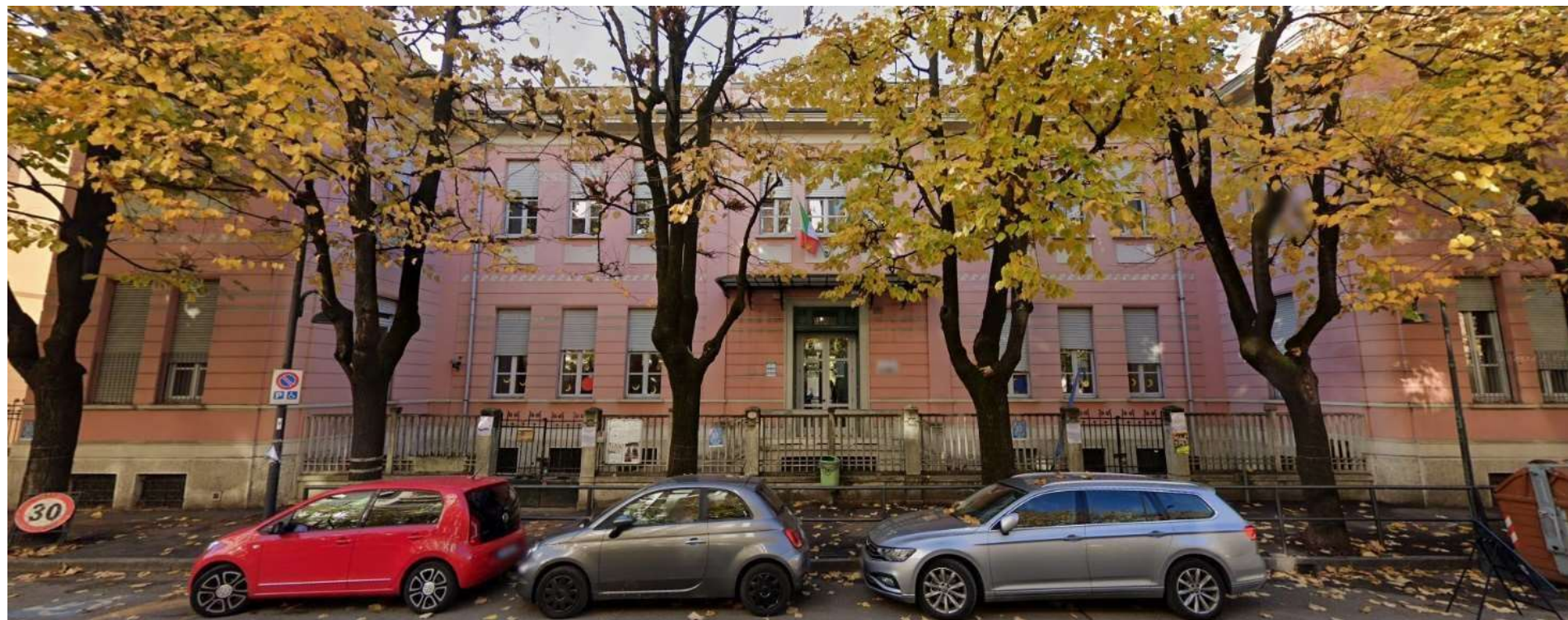
Vista Facciata principale
