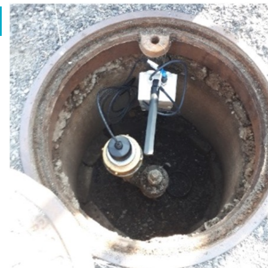
Figura 22 Sensore rilevamento rumore
