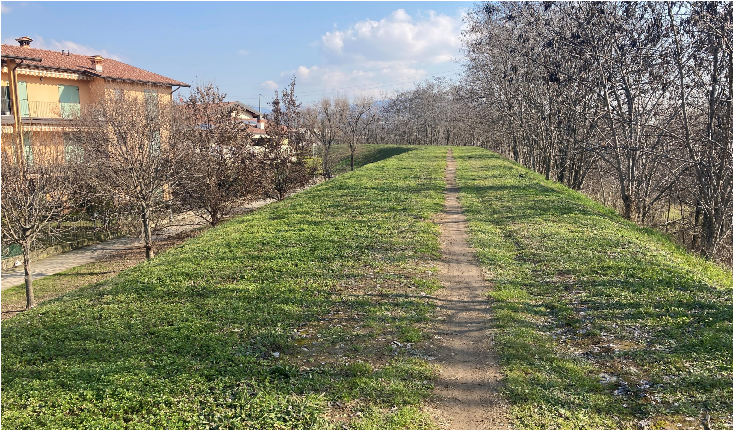
VISTA 1 – STATO DI FATTO - SPONDA RONCADELLE
