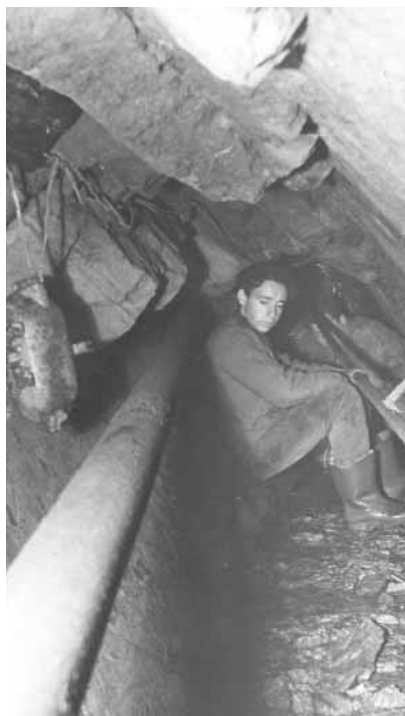
Comune di Collio: Fonte minerale Busana, interno captazione (st. n° 203).
