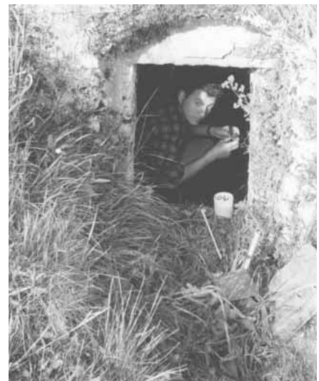
Captazione per il lavatoio di Vico (st. n° 338).
