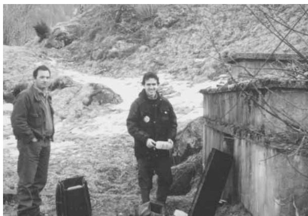
Captazione "Tezzone" (st. n° 100).
