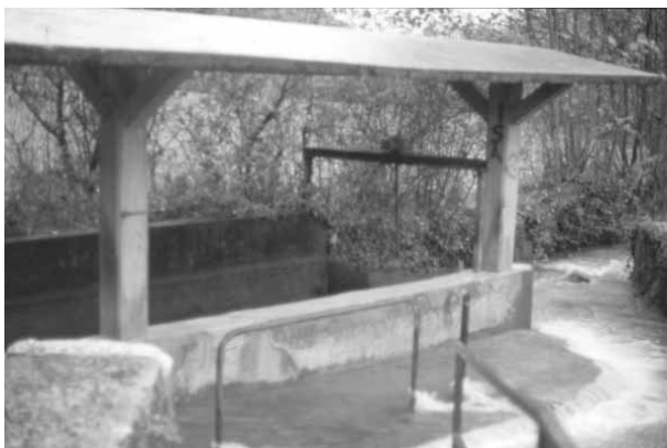
Sorgente Pedemonte, lavatoio e rivo.
