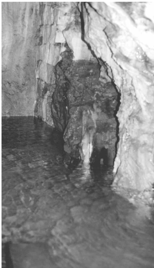
Captazione "Vignola", interno della captazione (st. n° 36).
