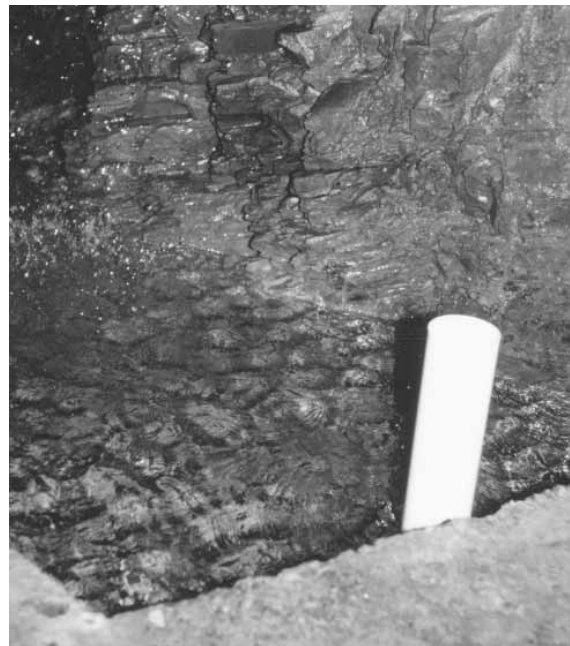
Captazione "Motta 2" (st. n° 103).
