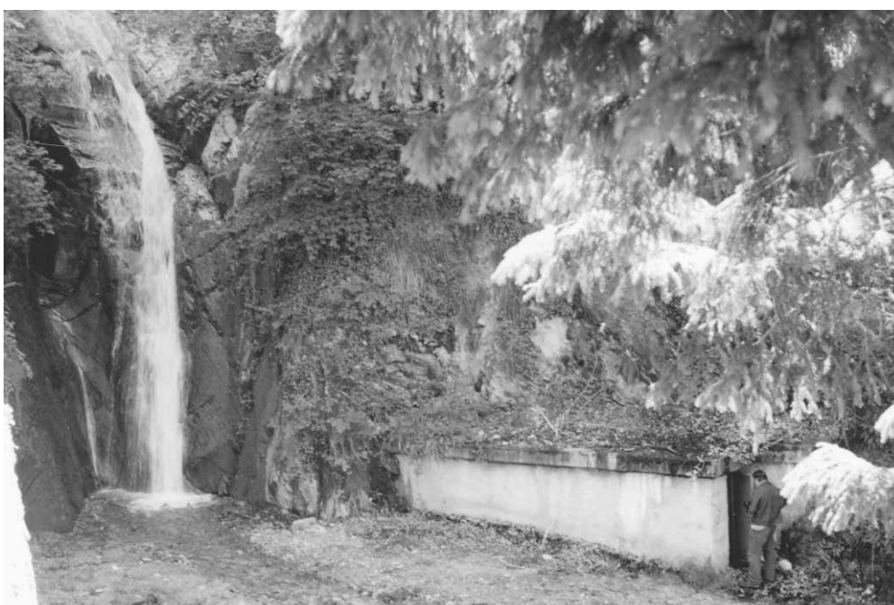
Captazione "Vignola", esterno (st. n° 36).
