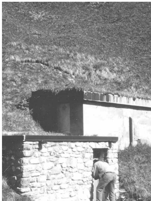
Captazione "Mureschi" (st. n° 27).
