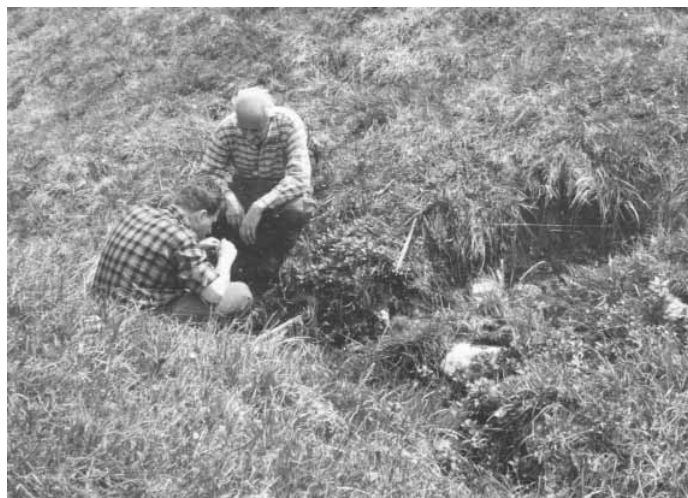
Altra permeazione nei pressi di C. Besta (st. n° 450).
