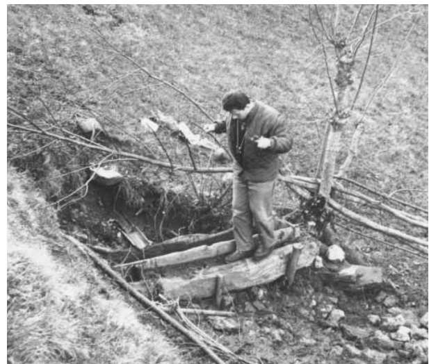
Sorgente in Val di Pu, rustico abbeveratoio in legno (st. n° 320).
