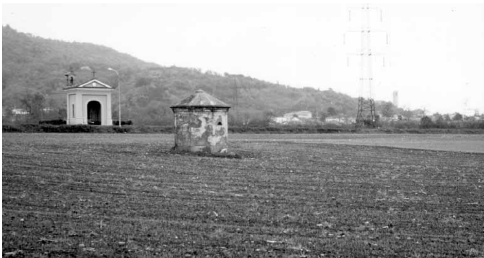
Comune di Capriolo: Pozzo San Lorenzo, esterno (st. n° 161).
