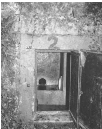
Captazione Gaina 2, esterno (st. n° 173).
