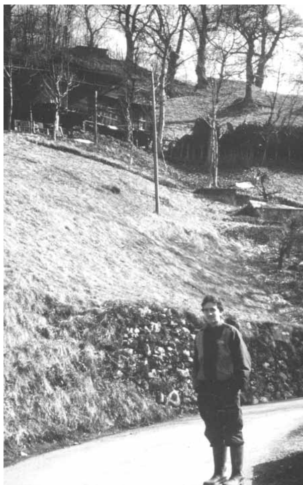
Captazione in località Giacche (st. n° 105).
