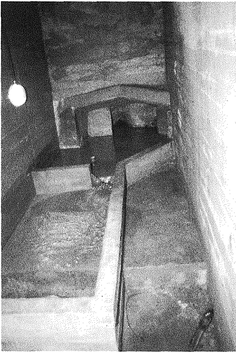
Foto 20 - Panoramica dell'ingresso delle captazioni storiche del "Rio Re" (Albino, staz. n° 301 BG).
