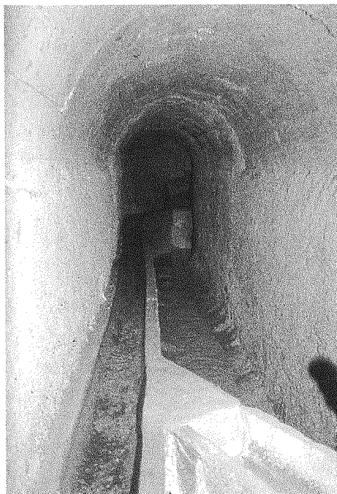
Foto 27 - Captazione "Tinelli 1", canalizzazioni interne (Ponteranica, staz. n° 315 BG).
