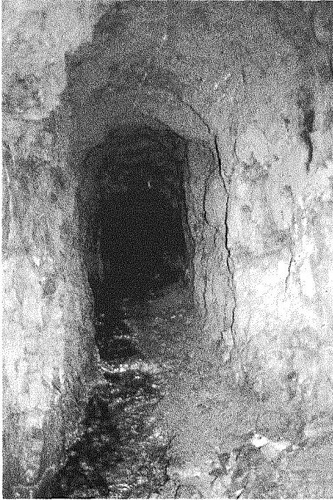
Foto 69 - Galleria di captazione della sorgente "Scapla" (Roncola Imagna, staz. n° 393 BG).
