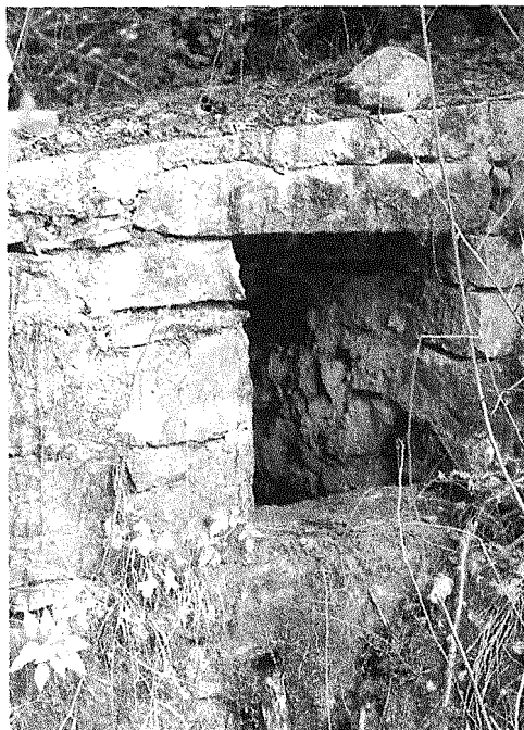
Foto 41 - Vecchia captazione per alimentare la "Fonte della Lavina" (Vedeseta, staz. n° 340 BG).
