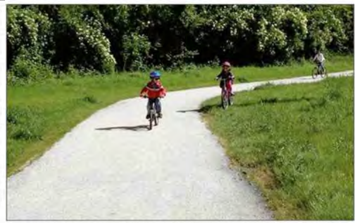
ESEMPIO DI PERCORSO IN GRANULATO DI DOLOMIA
