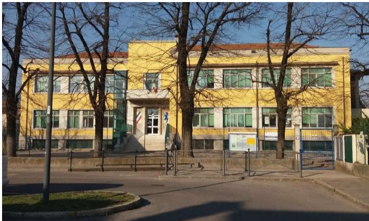
Vista facciata principale.
