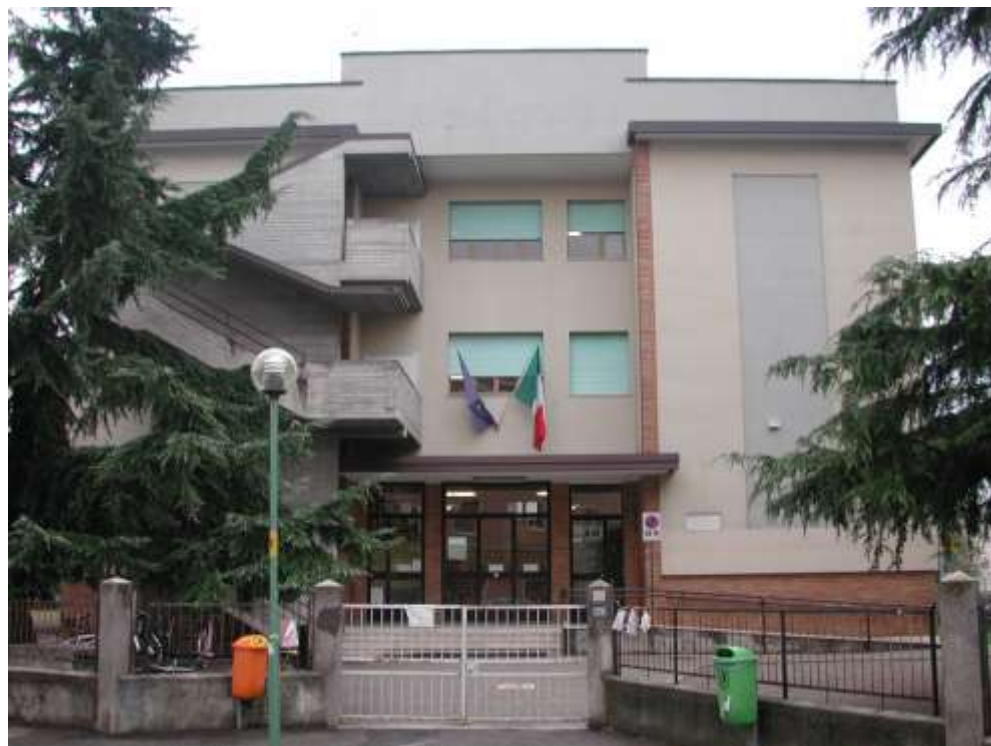
Vista facciata principale.
