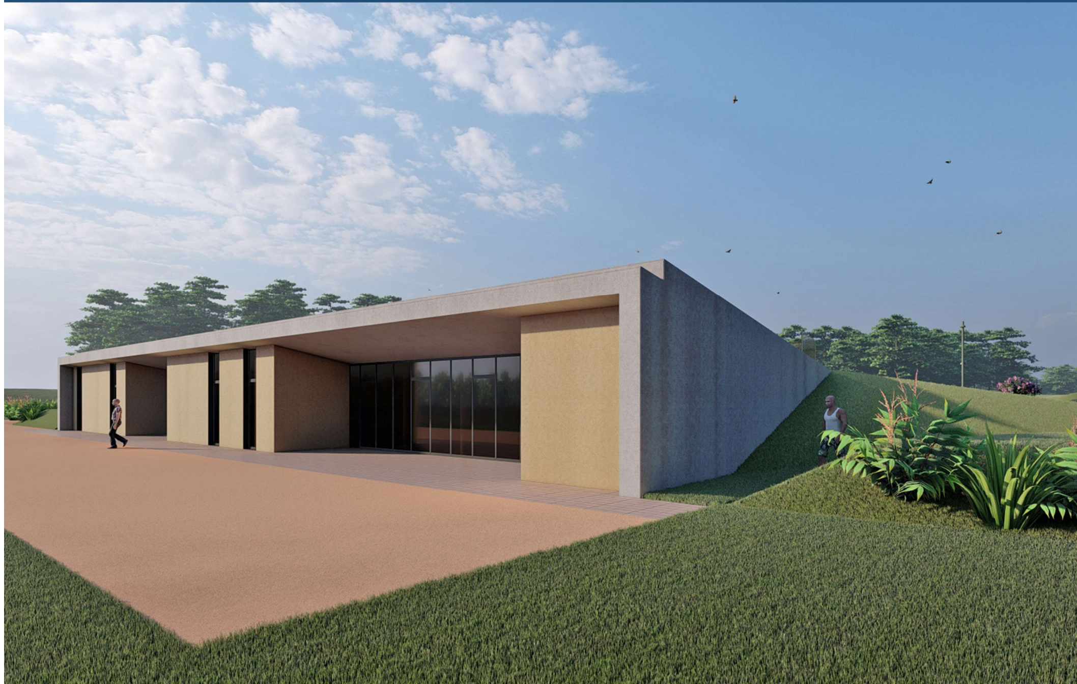
L'INTERVENTO VISTO DA NORD-EST
