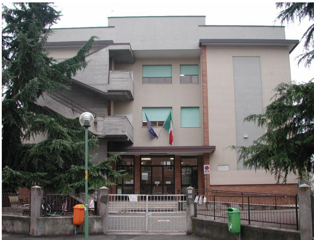
Vista facciata principale.
