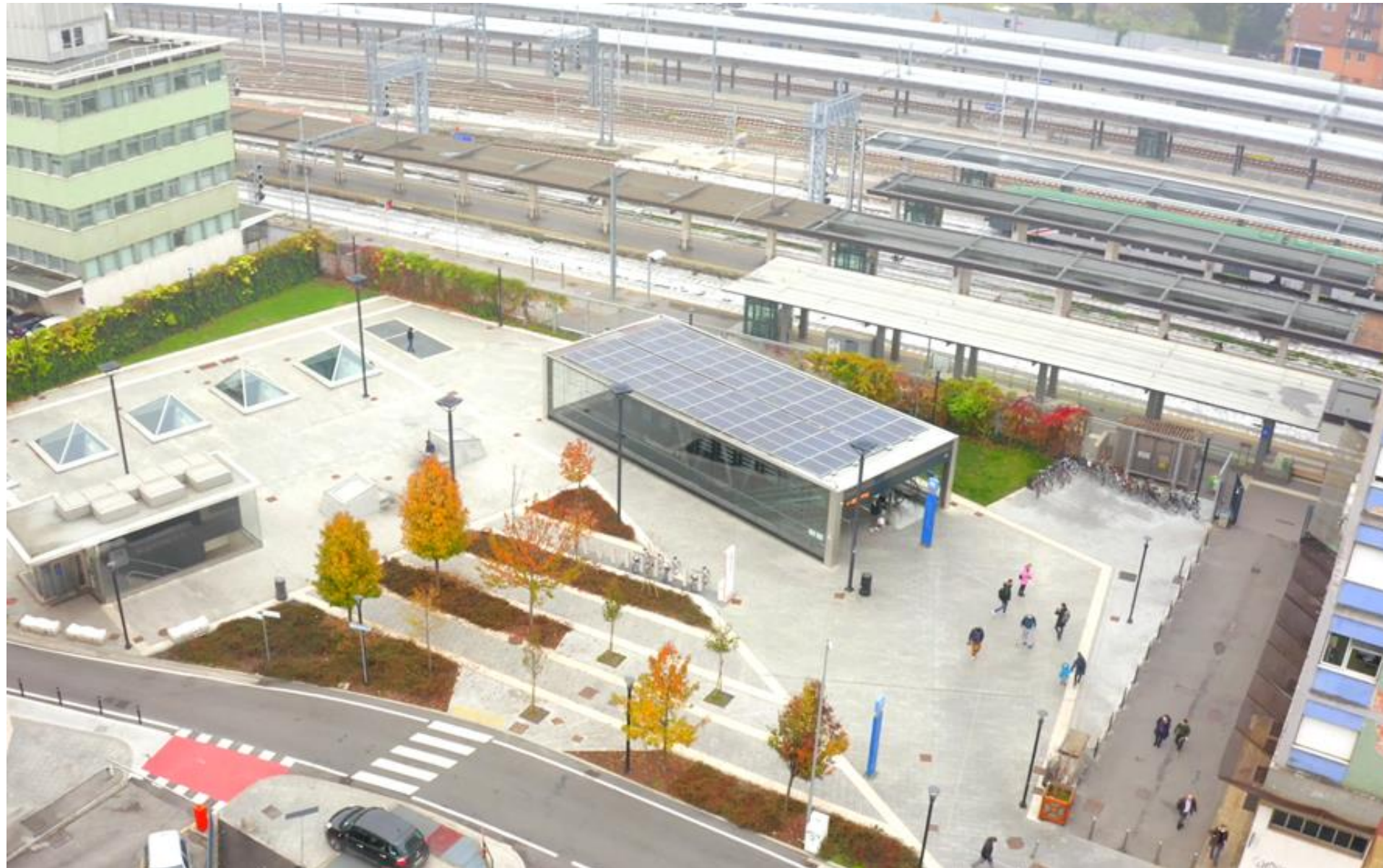
Sistemazione superficiale piazzale Stazione fermata FS della Metropolitana
