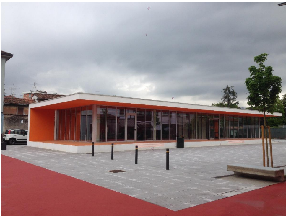
Vista da sud-est dell'intervento
