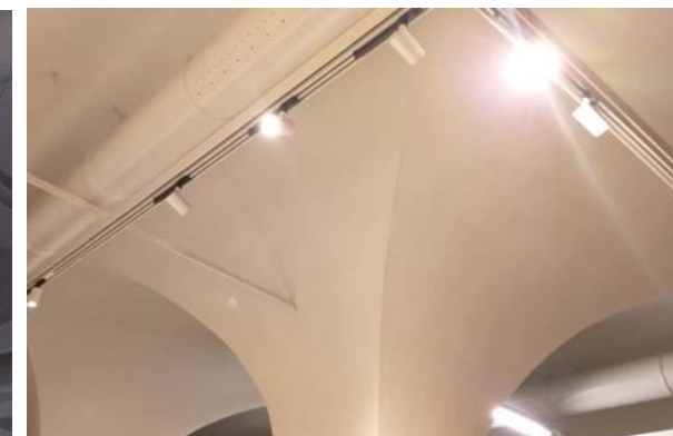
Particolare installazione profilato metallico e apparecchi illuminanti
