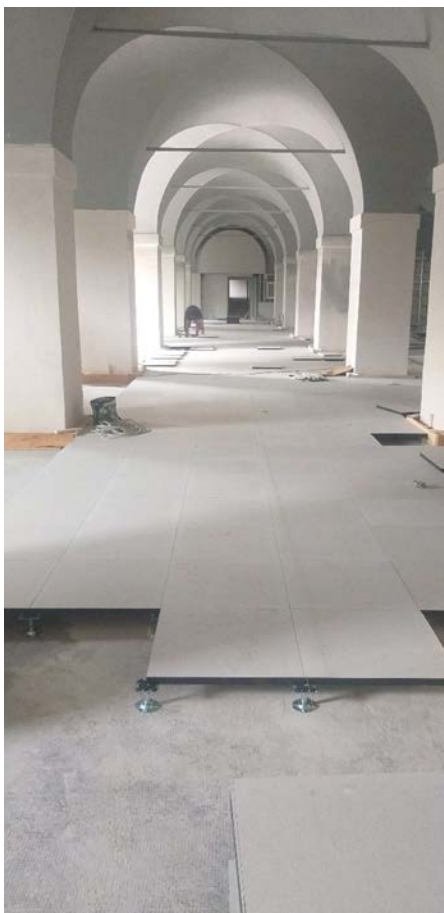
POSA STRUTTURA PORTANTE DEL PAVIMENTO FLOTTANTE
