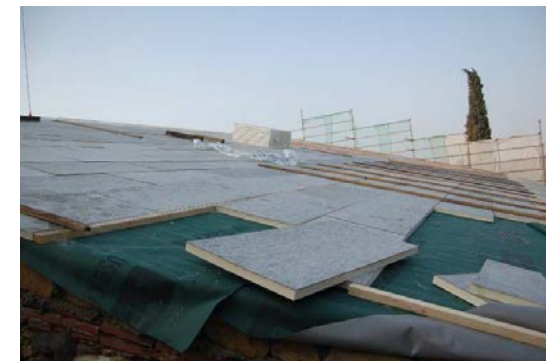
POSA BARRIERA AL VAPORE E PANNELLI ISOLANTI
