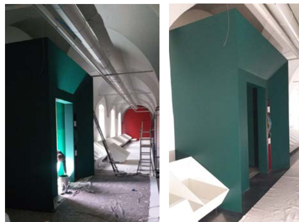
PRESE FOTOGRAFICHE BUSSOLA IN FASE DI CANTIERE
