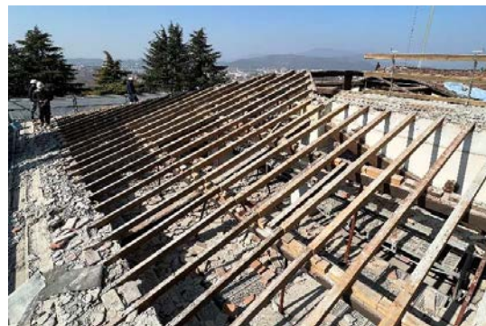
RIMOZIONE DELL'ASSITO, TAVELLE E MASSETTO
