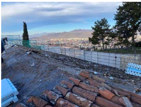
RIMOZIONE GUAINA IMPERMEABILIZZANTE
