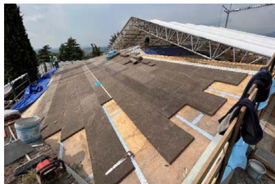
POSA BARRIERA A VAPORE, MULTISTRATO FENOLICO, ASSITO E PANNELLI ISOLANTI
