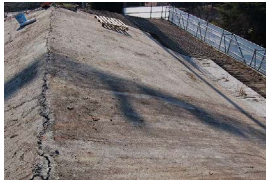
PULITURA DEL MASSETTO SOTTOSTANTE
