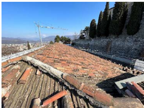
RIMOZIONE COPPI A COMPLUVIO/DISPLUVIO
