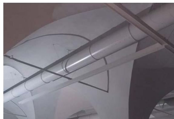
Posa impianti meccanici e trave metallica
