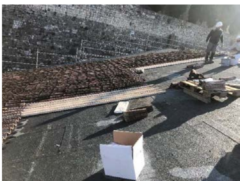
POSA COPPI CON GANCI DI FISSAGGIO IN ACCIAIO
