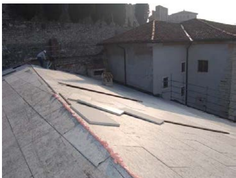
POSA PANNELLI ISOLANTI SU LISTELLI LIGNEI
