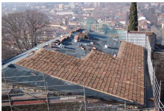
POSA COPPI CON GANCI DI FISSAGGIO IN ACCIAIO
