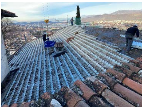
RIMOZIONE COPPI A COMPLUVIO/DISPLUVIO
