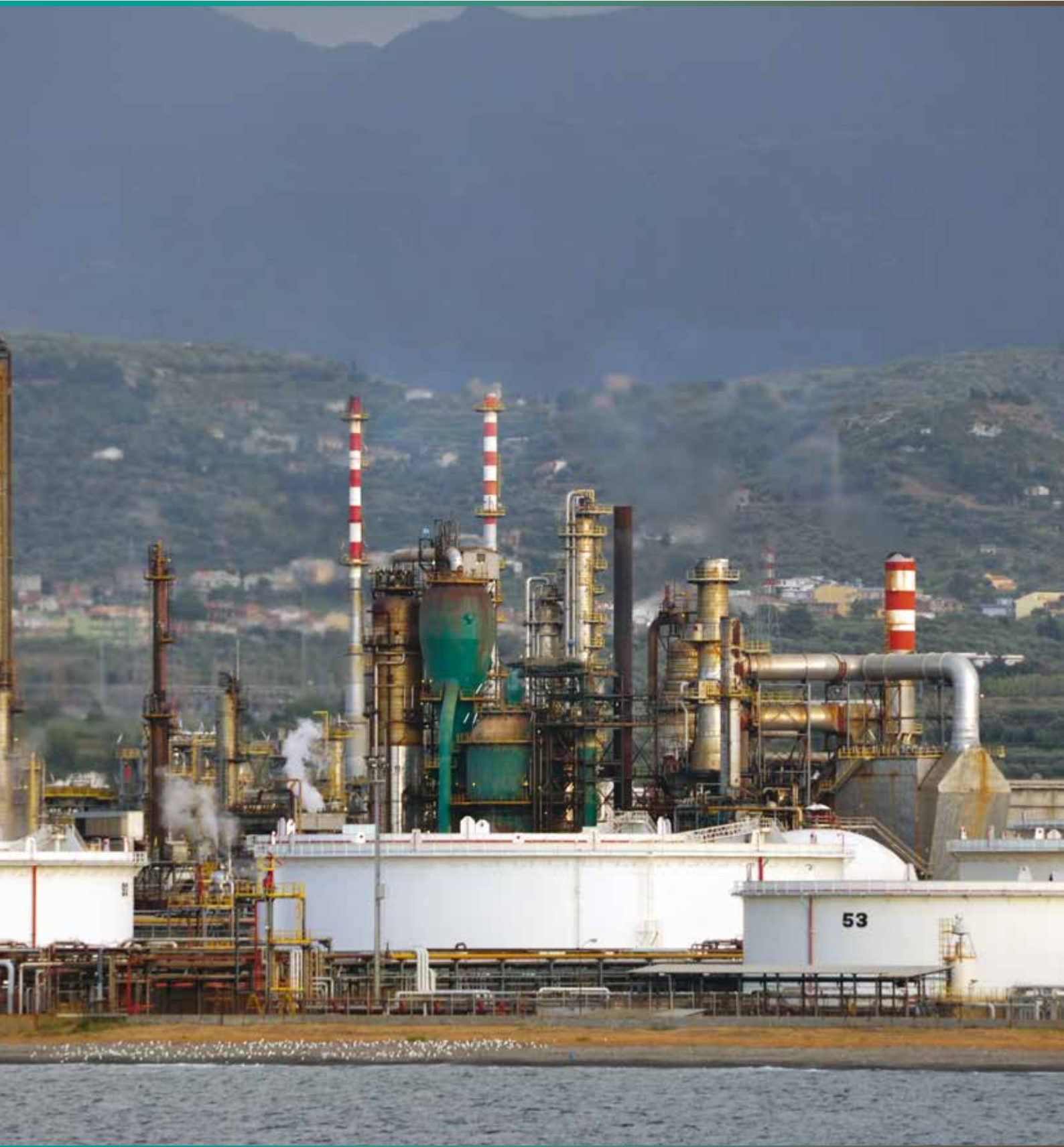
Foto 10.19 Impianti industriali Fonte MATTM Luca Grassi
