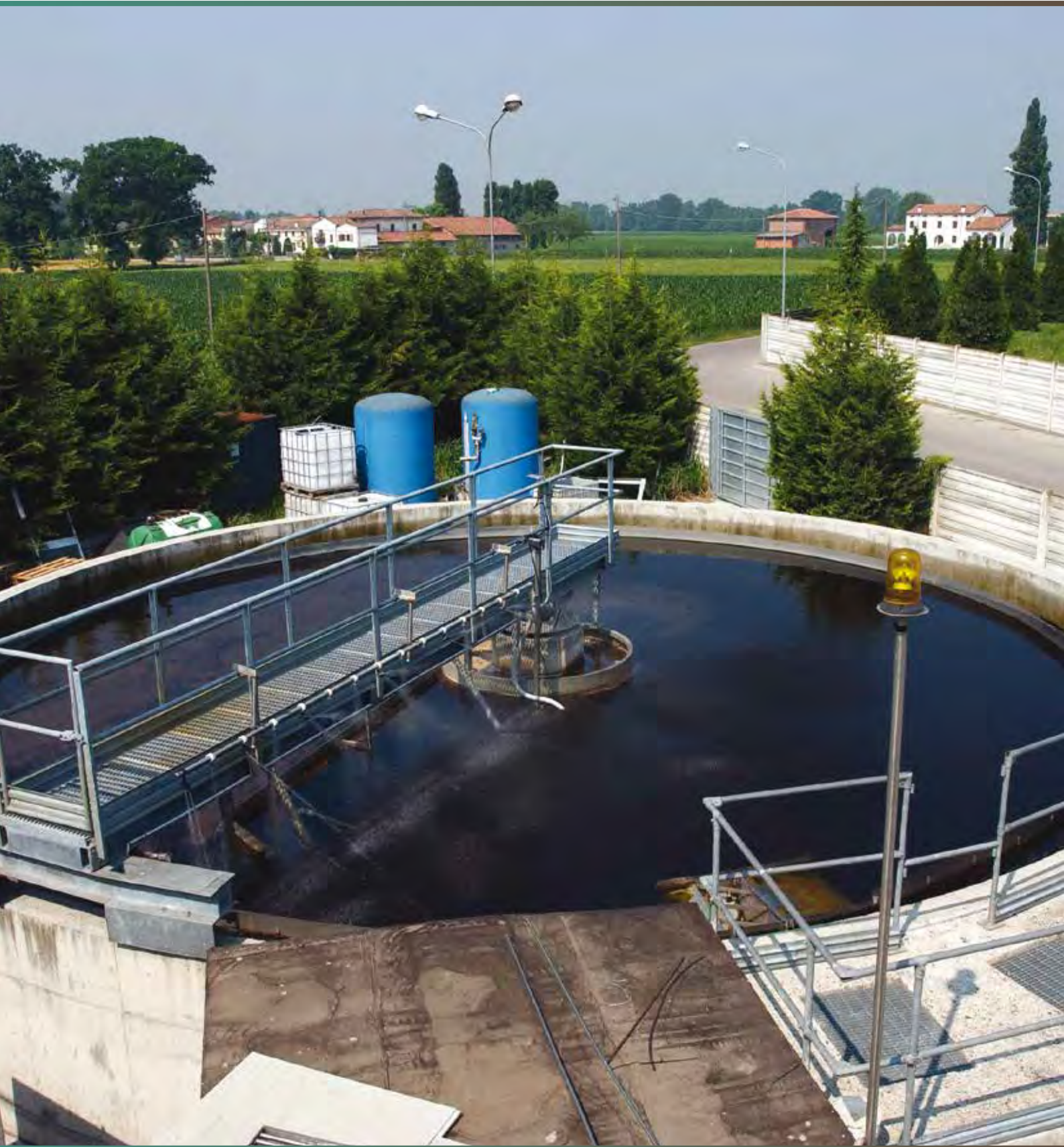
Foto 5.12 Sedimentatore con carroponete Fonte ISPRA Paola Orlandi
