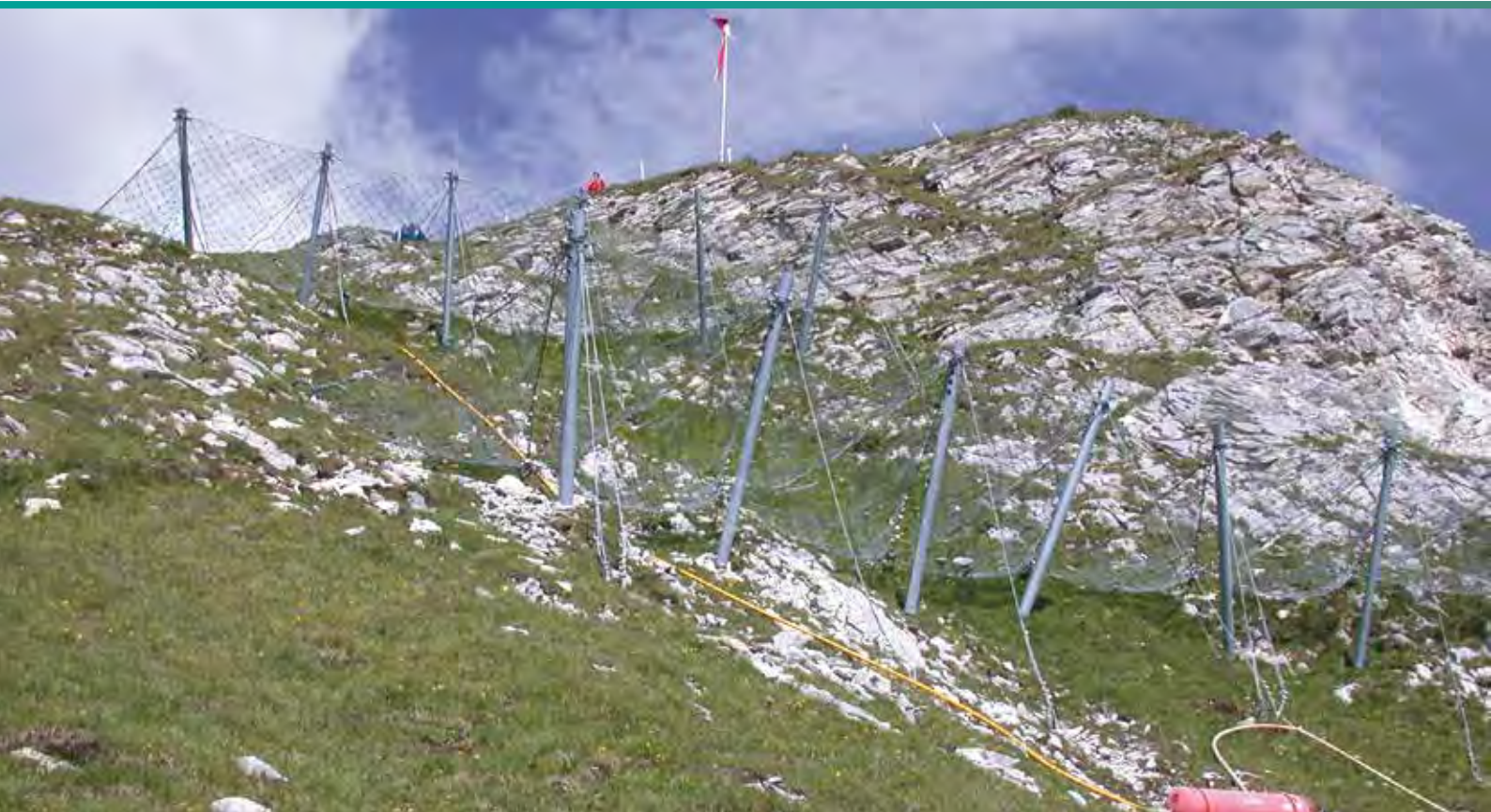
Foto 8.17 Opere in alveo Torrente Selvaspessa - Intervento 774/99 - Baveno (VB) Fonte ISPRA Elisa Brustia - Francesco Traversa - Marco Di Leginio
