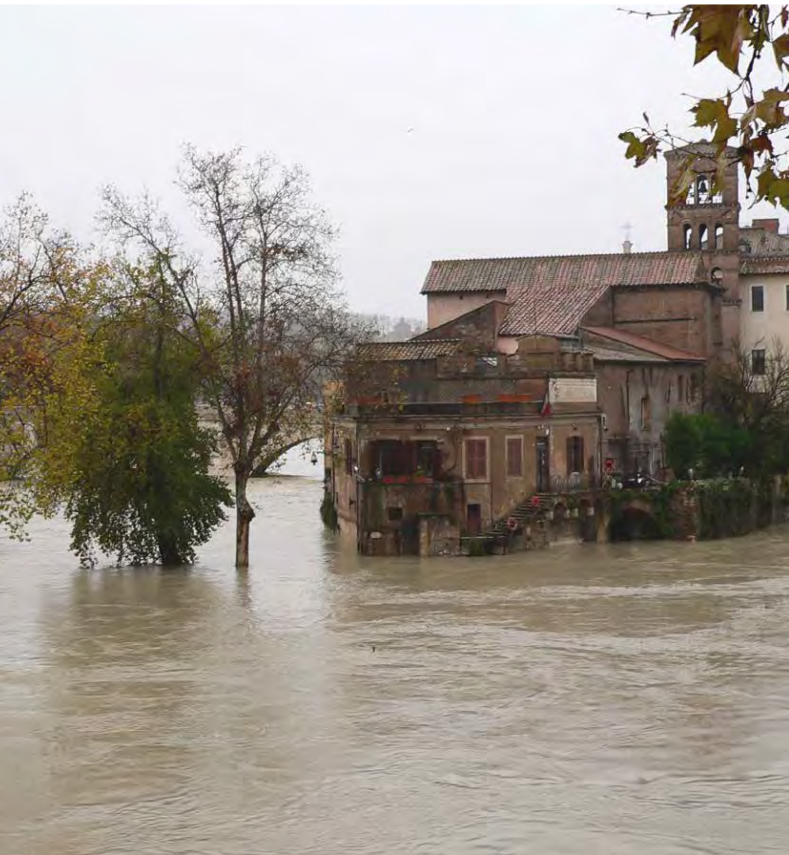
Foto 6.04 Alluvione Fonte ISPRA Franco Iozzoli
