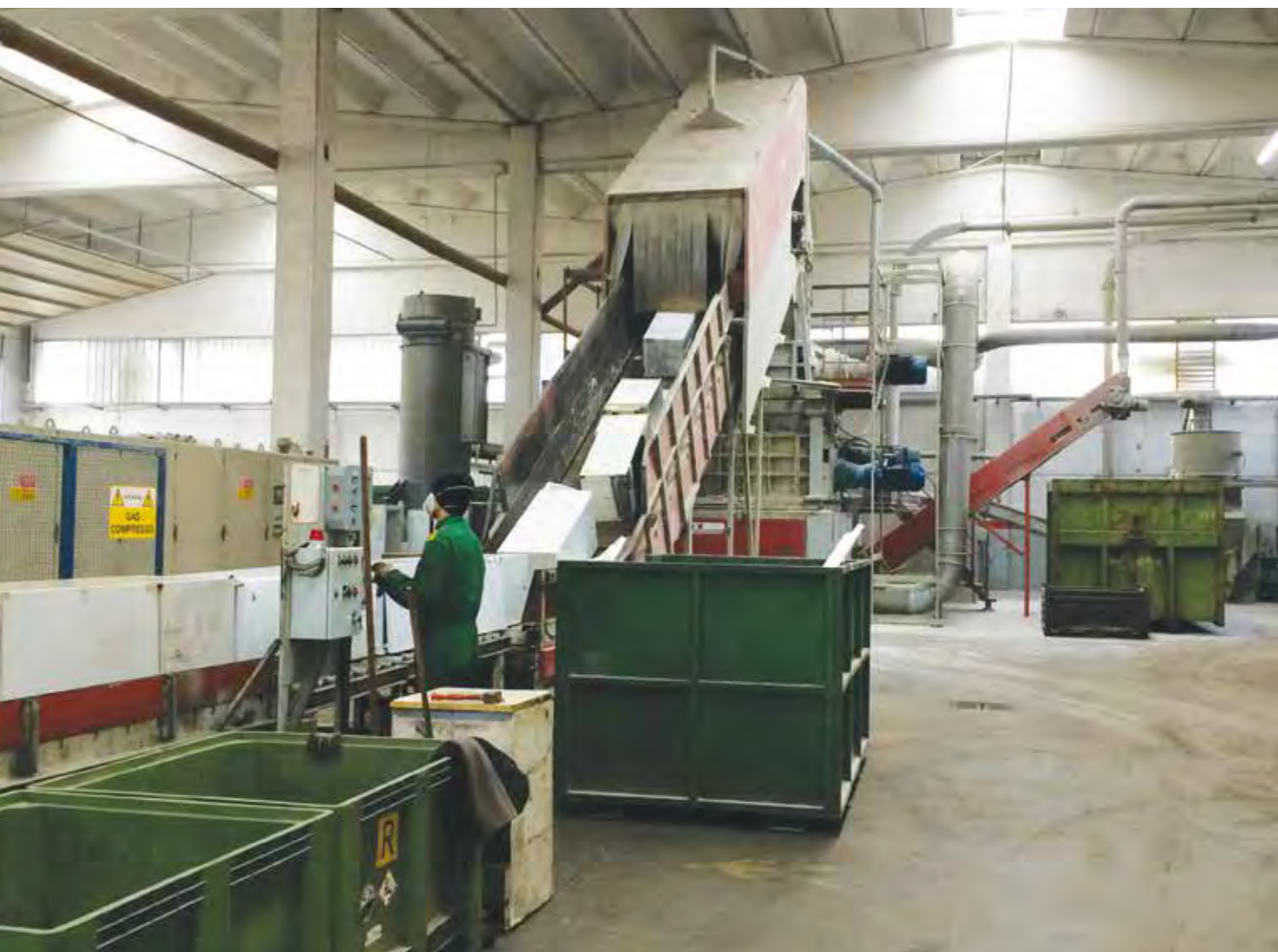
Foto 5.08 Impianto di riciclaggio Fonte MATTM
