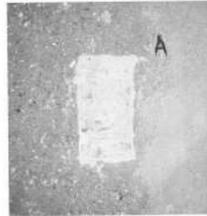
DESCRIZIONE : la muratura in mattoni risale alla temporatura del chiostro, occorsa durante i lavori di costruzione del santuario. L'intonaco del lato sinistro del sondaggio è identico a quello che copre tutta la facciata; quello a destra, più fine e liscio che lo sommonta, riveste i contorni delle finestre del santuario.
