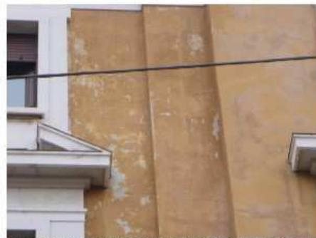
Foto 75 - Prospetto ovest - degrado delle superfici intonacate - alterazioni, macchie e lacune
