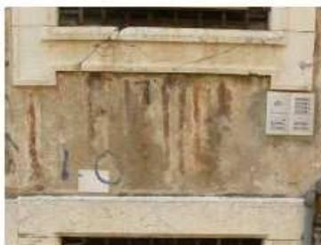
Fig. 12) Frattura del davanzale con caduta di frammenti di pietra.
