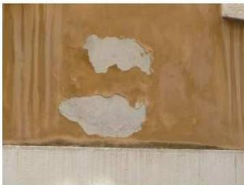
Foto 6 – percolamenti e distacchi di finitura – superfici intonacate
