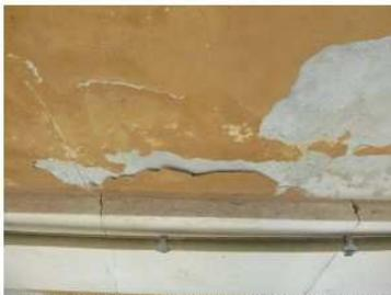
Foto 7 – distacchi di finitura – cavo telefonico sostenuto da corda in ferro arrugginita
