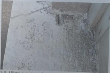
7, 8. 1 Piano, alloggiamenti per le grappe metalliche delle spalle.
