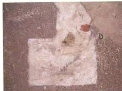
**DESCRIZIONE** : la muratura in mattoni risale alla temporatura del chiostro, occorsa durante i lavori di costruzione del santuario. L'intonaco bruciato è stato rimosso e sostituito con un intonaco cementizio, con carica di granulometria medio fine.
