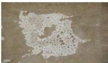
Fig. 6) Livello originario picchettato, utilizzato come substrato.
