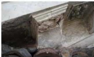
Il timpano di facciata è stato eseguito utilizzando malta di coccio pesto (campione analisi n. 9) sia per gli elementi a modellato sia per le parti piane. Il coccio pesto è stato rinvenuto nello strato di aggrappaggio (arriccio) sopra il quale sono risultati
