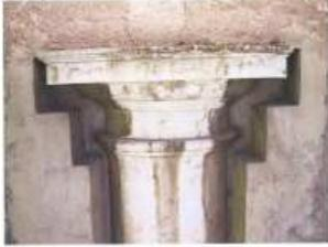
Gli intonaci che rivestono le modanature della cornice di gronda sono caratterizzati da cariche a granulometria fine; stesi sull'ossatura in mattoni sagomati sono trattati con latte di calce a fresco, finitura estesa anche al resto della facciata.
