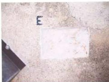
DESCRIZIONE : L'intonaco del lato destro del sondaggio è identico a quello che copre tutta la facciata; quello a sinistra, più fine e liscio che lo sormonta, riveste i costoni delle finestre del santuario. Rappezzo cementizio più in alto.
