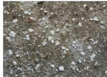
10. Intonaco di finitura eroso con presenza diffusa di calcinacci.
