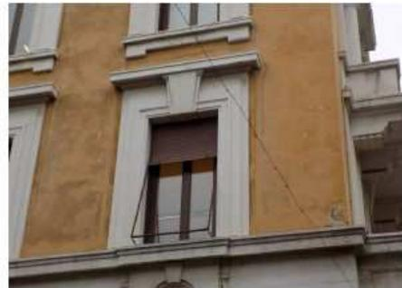
Foto 74 - Prospetto ovest - degrado delle superfici intonacate - alterazioni, macchie e lacune
