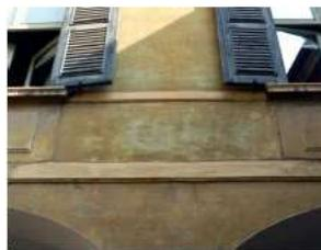
16. Corte interna, prospetto a sud, primo livello di coloritura tornato in luce per il dilavamento delle tinteggiature successive.
