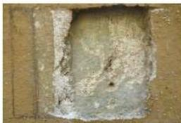
18. Corte interna, prospetto verso ovest, primo livello di coloritura, nascosto dai rivestimenti neoclassicistici.
