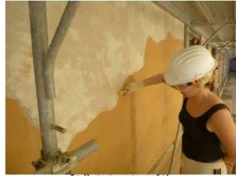
Foto 33 - rimozione rasatura superficiale
