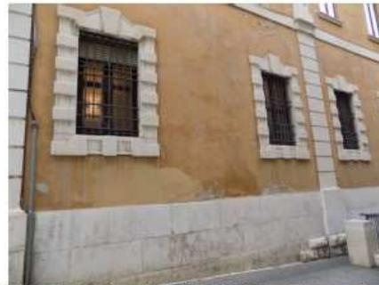
Foto 4 – parte bassa into est – evidenze problematiche di umidità che interessano l'intonaco e scritte vandaliche
