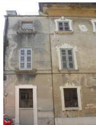
Fig. 4) Corpo di fabbrica successivo, aggiunto sul lato est.
