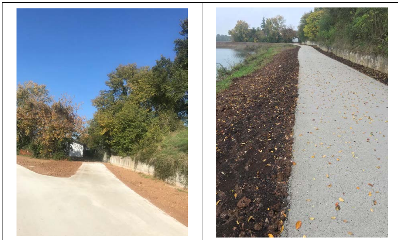
Figura 3-3: Esempi di finitura in Calcestre realizzata lungo il fiume Oglio.
