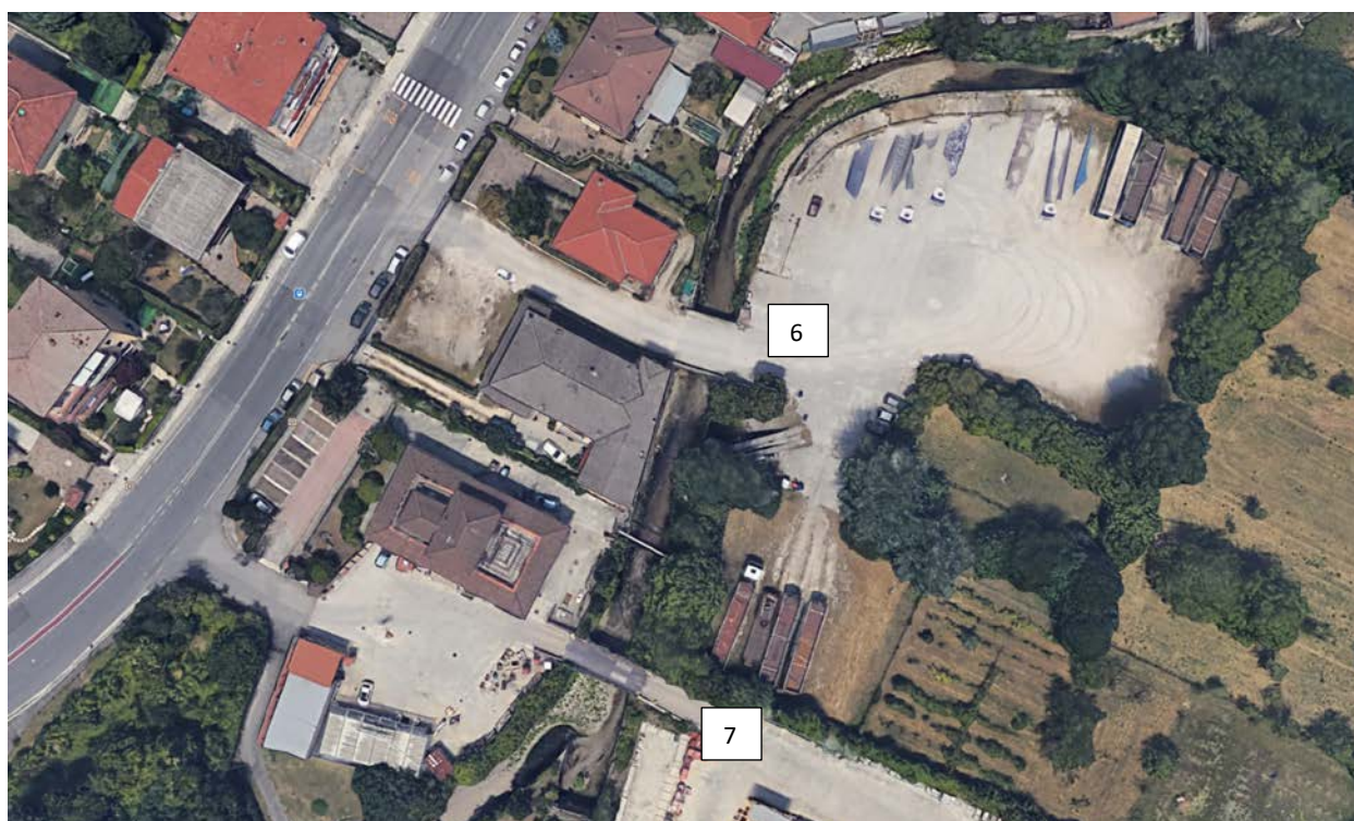
Figura 4-9: Estratto Google Maps della zona dei ponti privati 6 (deposito automezzi) e 7 (deposito materiali edili)
