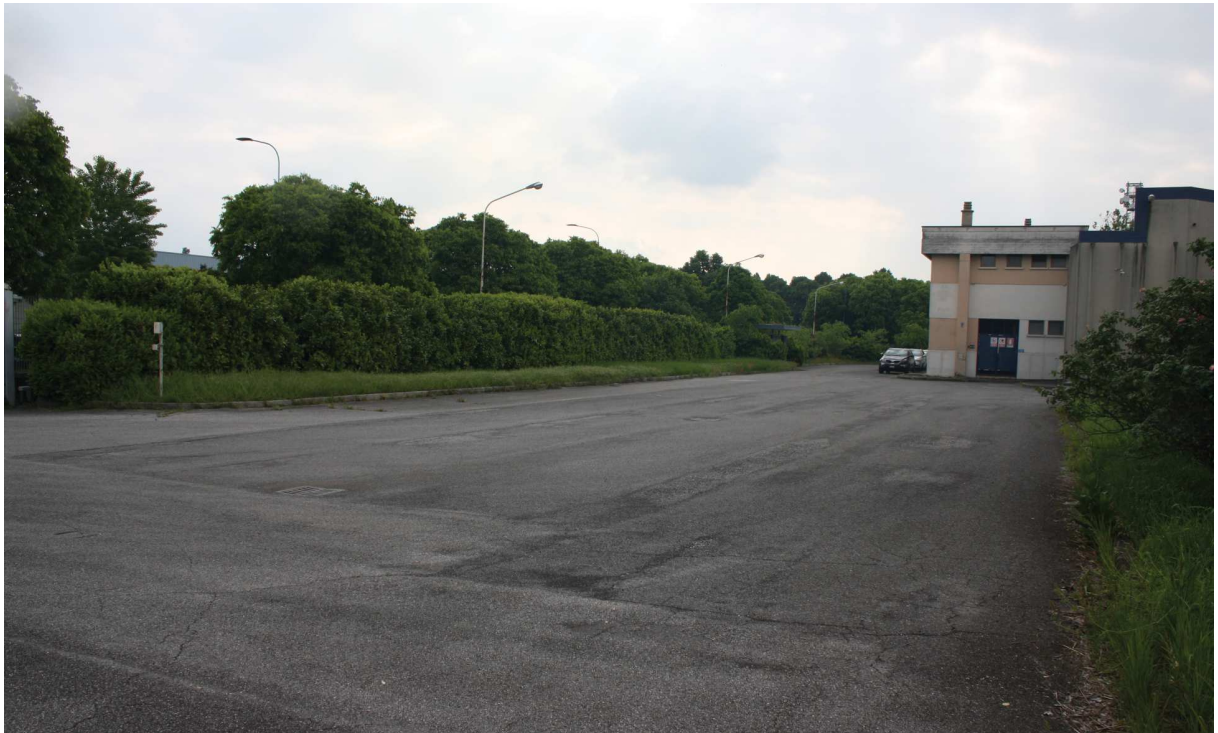
fotografia n.2 - vista del piazzale a nord dell'area
