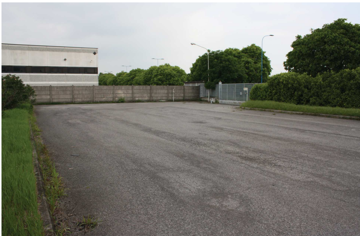
fotografia n.3 - vista del piazzale a nord dell'area verso il cancello carraio d'ingresso
