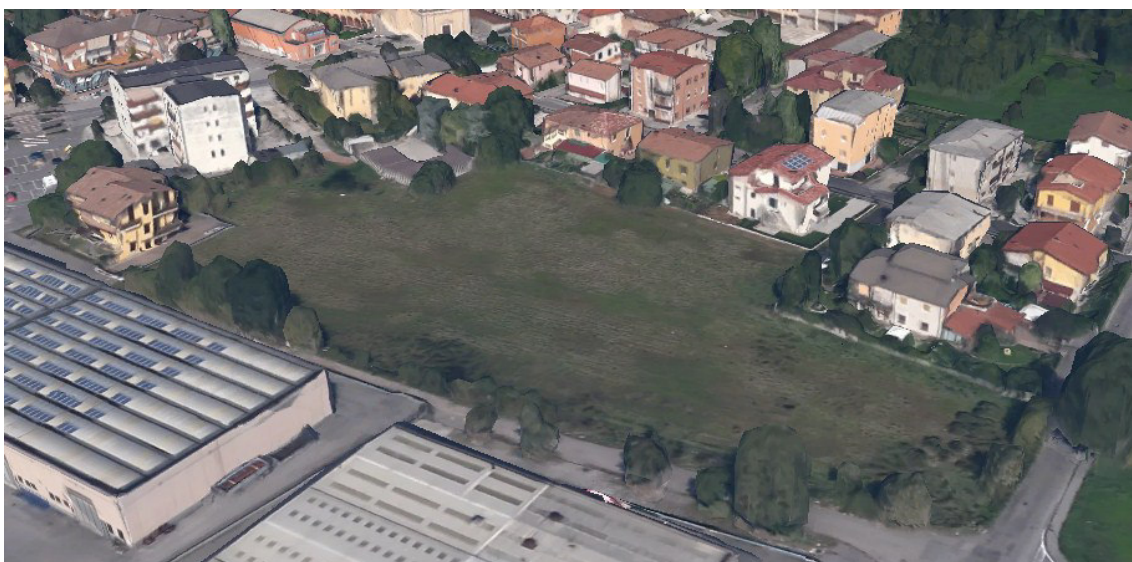
Figura 14: Vista Stato attuale area oggetto dell'intervento (Stato di fatto)
