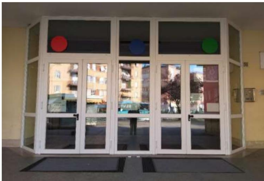
Figura 15: Scuola secondaria di primo grado Carducci, serramenti prima e dopo l'intervento
