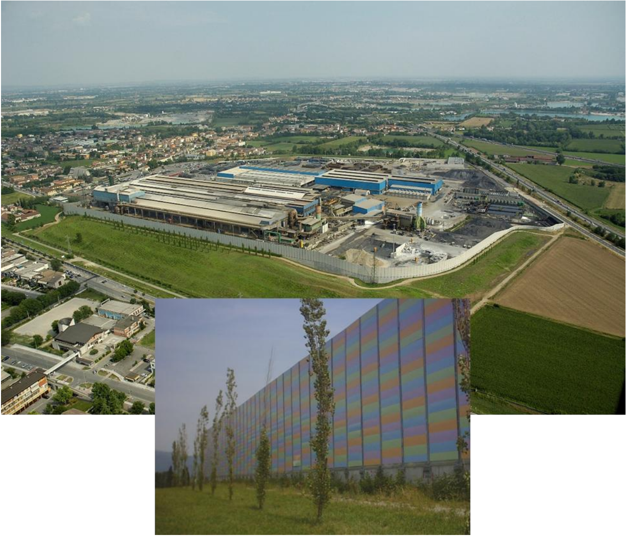
Figura 16: vista area dello stabilimento Alfa Acciai e immagine delle barriere antirumore installate
