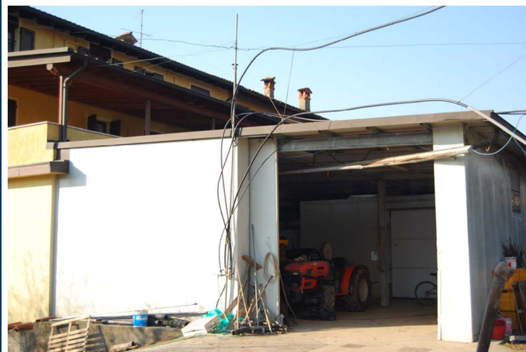
PUNTO DI VISTA 2 – INGRESSO LOCALE “A”
