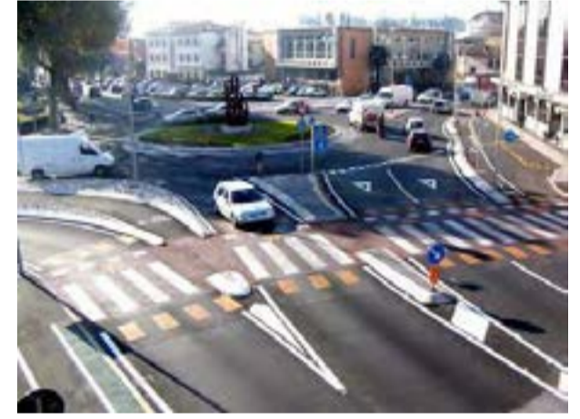
Attraversamenti rialzati sui rami afferenti alla rotatoria, Padova.
