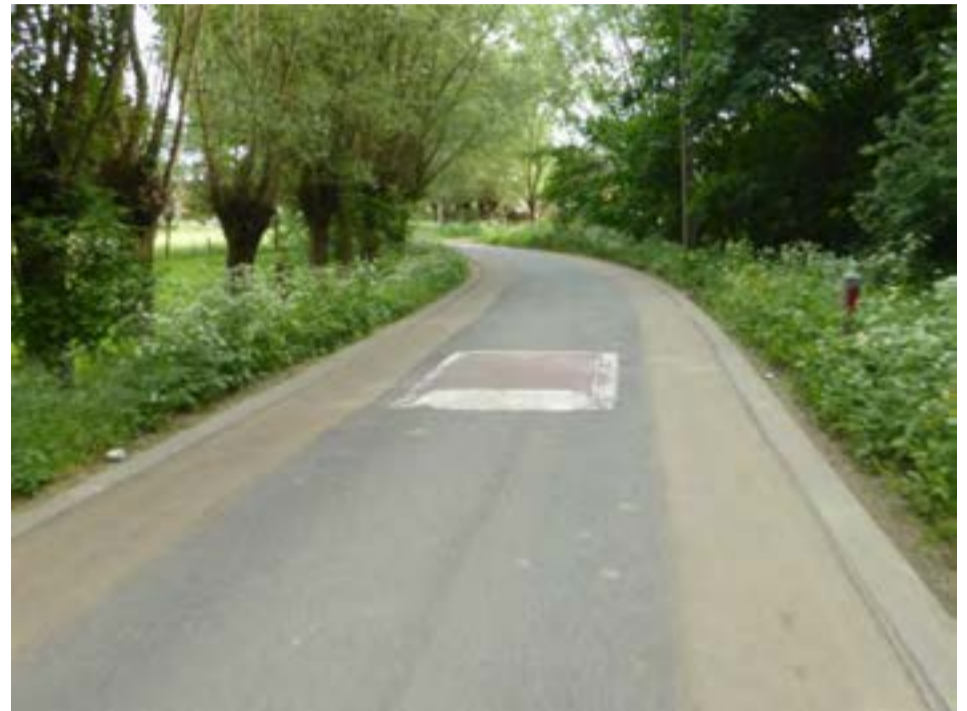
Interventi di moderazione del traffico nella Zona 30 di via Dante a Rovereto e applicazione di cuscinio berlinese e colorazione delle corsie in una strada extraurbana.
