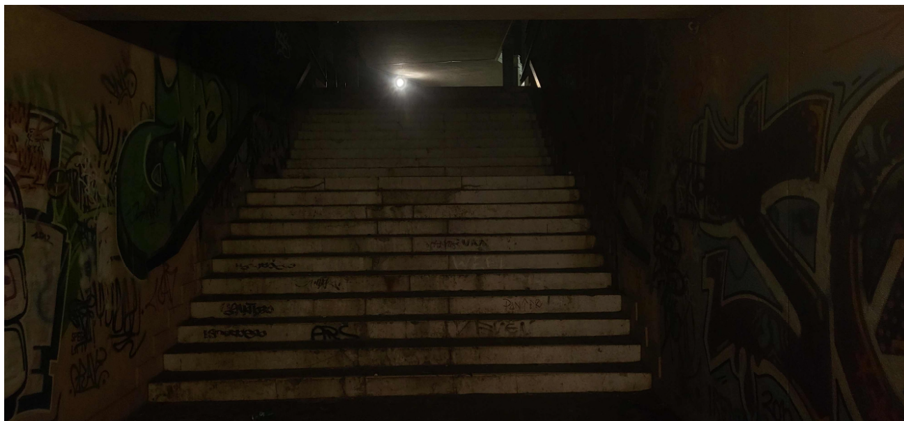
SCALE LATO SUD ° SCARSAMENTE ILLUMINATO
