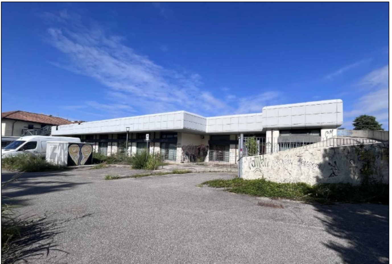
Vista 12 zona parcheggio retrostante Via Pascoli
