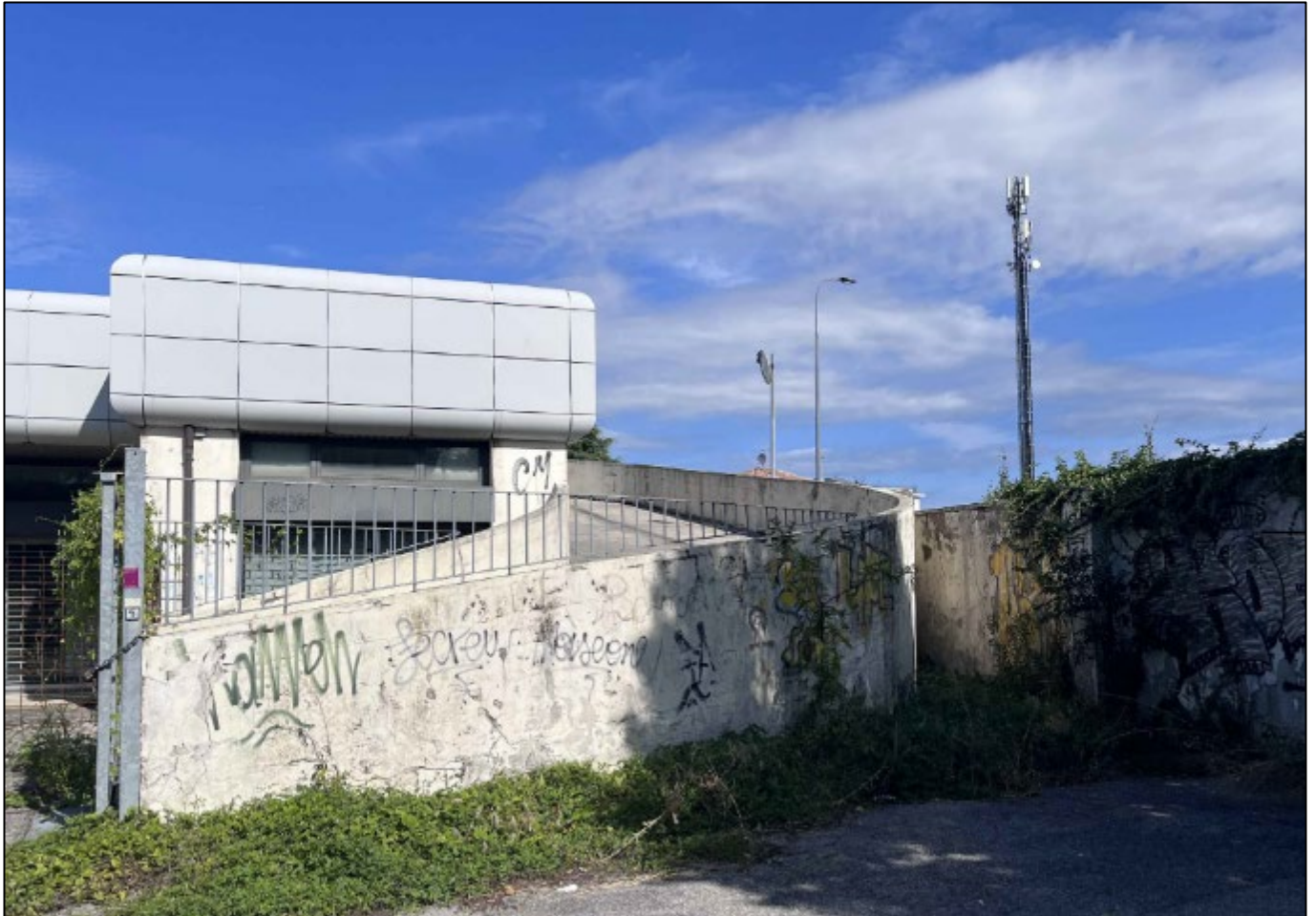
Vista 11 zona parcheggio retrostante Via Pascoli
