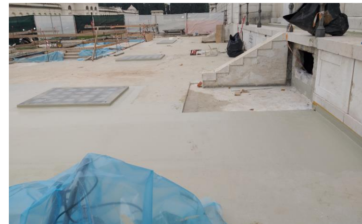
IMPERMEABILIZZAZIONE SOLETTA DEL CAMMINAMENTO E DEI SOLAI
