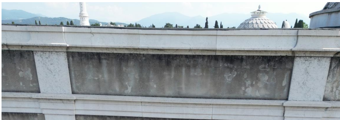
IMPERMEABILIZZAZIONE COPERTURA PER RISOLVERE PERCOLAZIONI E MACCHIE DI UMIDITÀ DEGLI INTONACI E SEGUITO DELLE INFILTRAZIONI DELLE ACQUE METEORICHE DALLA GUAINA
