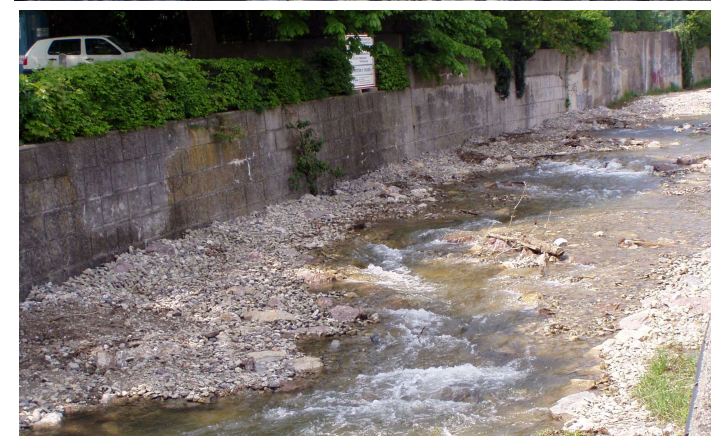
APPENA DOPO LA COSTRUZIONE DI UNA RAMPA SINUOSA IN MASSI CICLOPICI 3 / 2006
