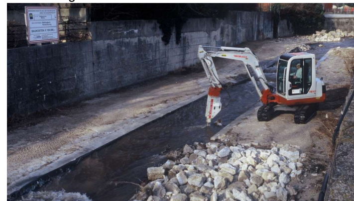
DURANTE LA DEMOLIZIONE DELL'ALVEO IN CEMENTO
