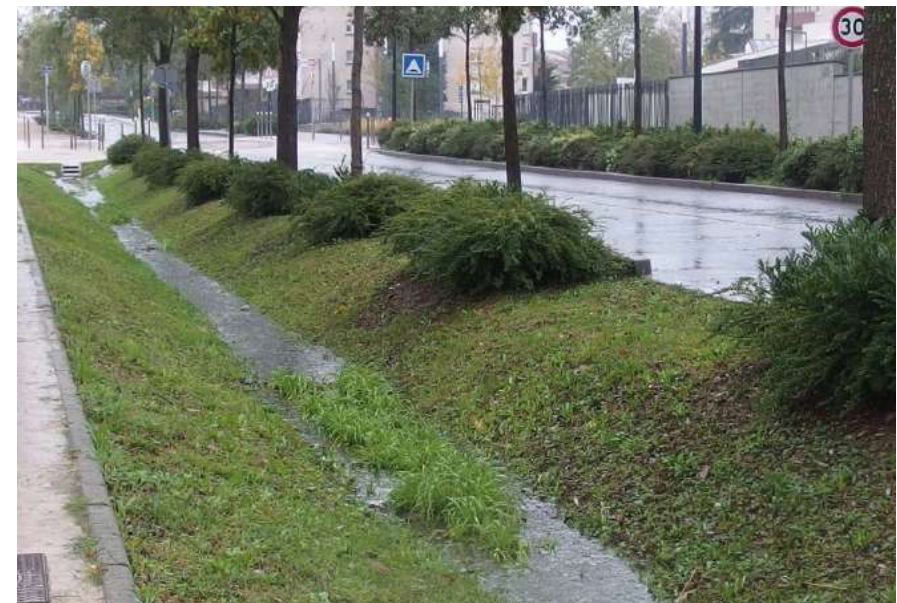
Intervento su nuovo filare, ove viene realizzato un fosso continuo
