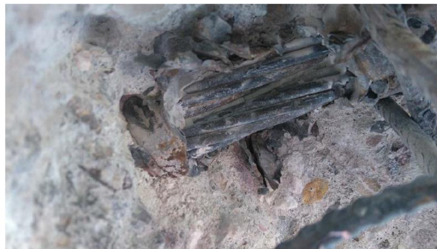
Figura 2 – si intravede, oltre il primo strato di fili, il fascio dei trefoli di precompressione.
