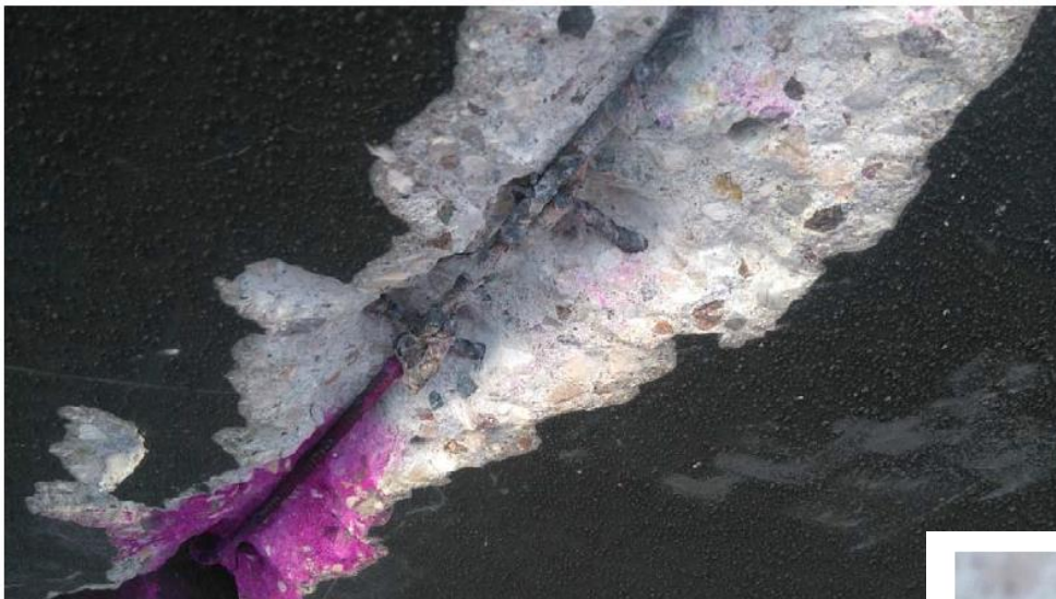
Figura 1 – immagine dell'armatura lenta ripresa dall'intradosso.
