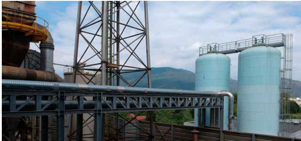
Recupera l'energia dissipata dal sistema di raffreddamento dell'impianto fumi dell'acciaieria, per contribuire al fabbisogno energetico degli abitanti di Brescia, attraverso una stazione di scambio energetico ad alta efficienza, collegando il processo siderurgico con la rete di teleriscaldamento A2A.
