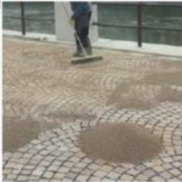
INTASAMENTO DELLE FUGHE
