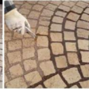
RESINATURA DELLA PAVIMENTAZIONE
